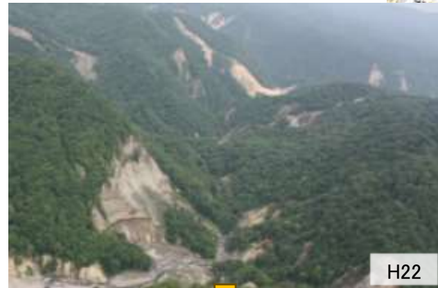
【①湯ノ倉 復旧状況】
