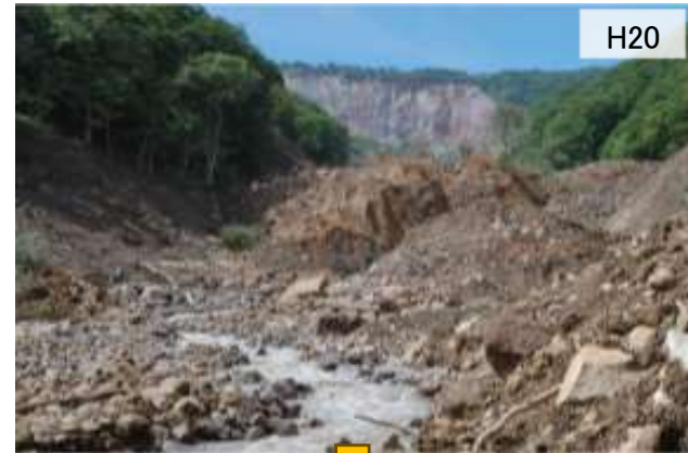
【①産女川上流 溪間工整備状況】
