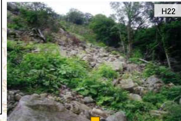
【②真湯 復旧状況】
