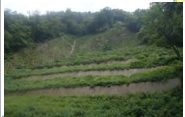
復旧状況(R5年)
