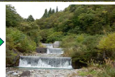
復旧状況(R5年)
