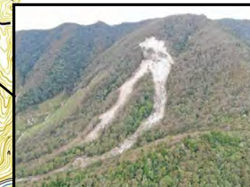
H30年に発生した崩壊地
