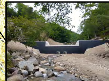
復旧状況(R5年)
