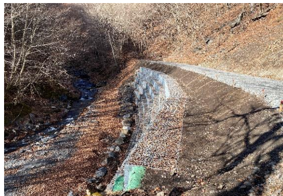
林道（林業専用道）開設
