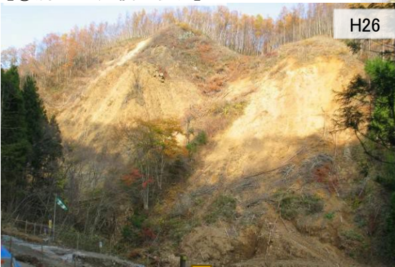
【①洞万区域 復旧状況】
