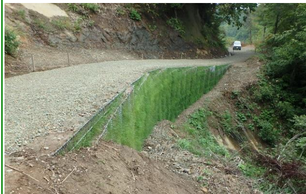
林道（林業専用道）開設
