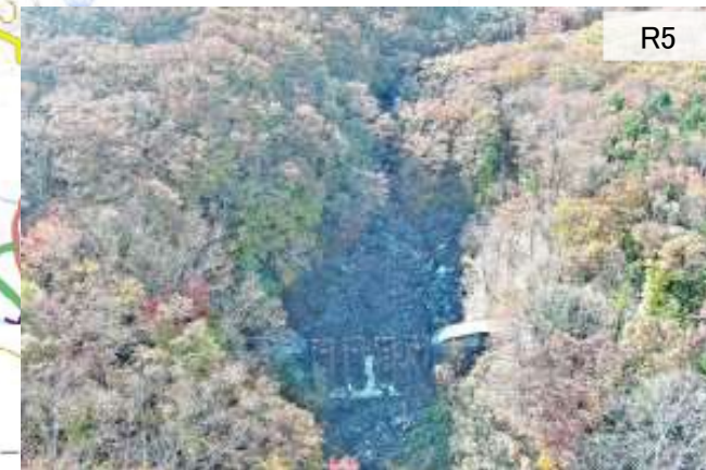
【③熊沢支流 溪間工整備状況】
