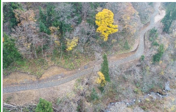
林道（林業専用道）開設
