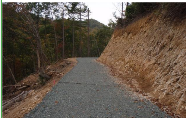
林道（林業専用道）開設
