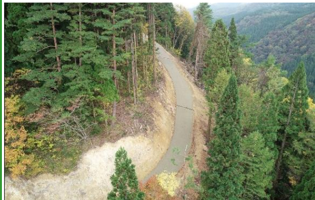
林道（林業専用道）開設
