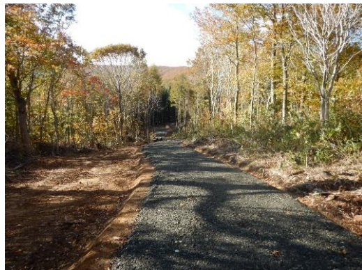
林道（林業専用道）開設
