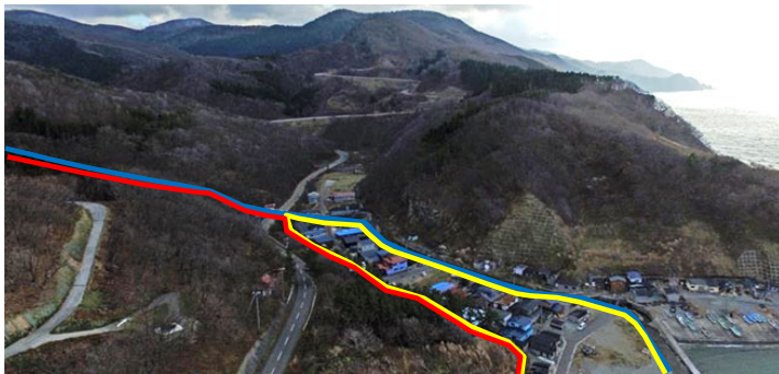
① 保全対象(人家、国道338号)
