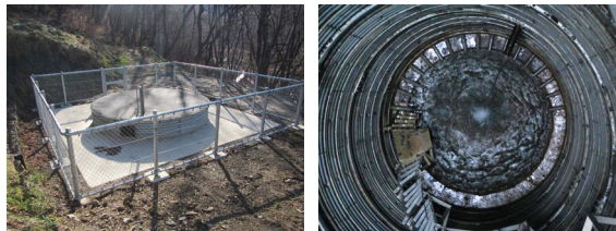
③ 集水井工と集水ボーリング工
