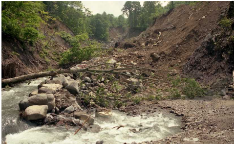
木地屋川 荒廃状況
