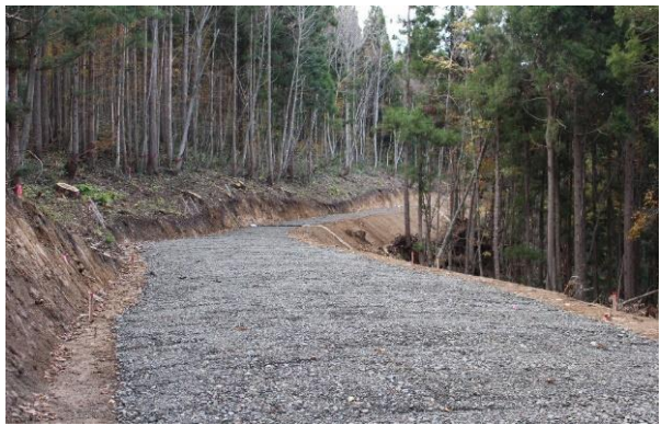
林道（林業専用道）開設
