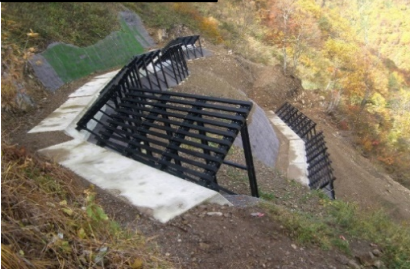
【H25完成】落石防護柵
