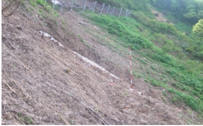
【着手前】落石防護柵
