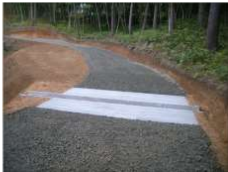
林道（林業専用道）開設
