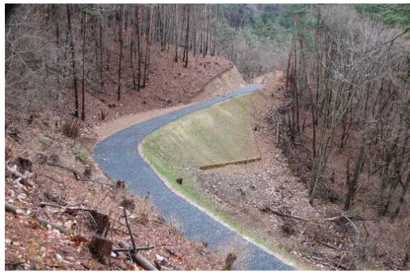
林道 (林業専用道) 開設
