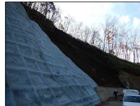
令和4年度 東濃森林管理署 高時山林道改良工事
