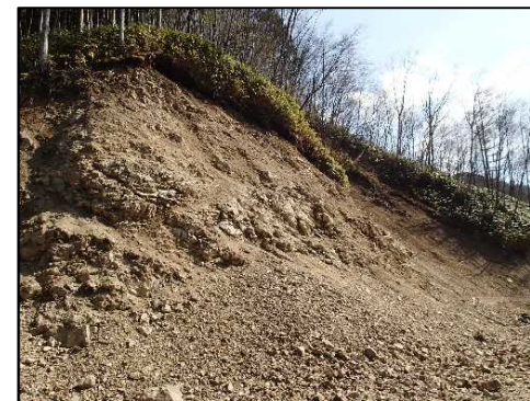
路網整備事業 (林道改良工事)
