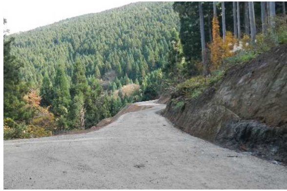
林道（林業専用道）開設
