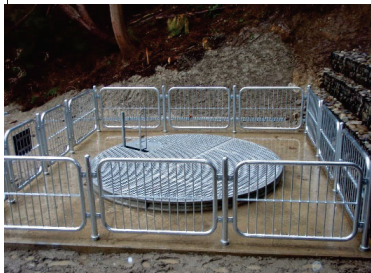
集水井工設置状況
