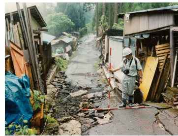
③ 被災状況
