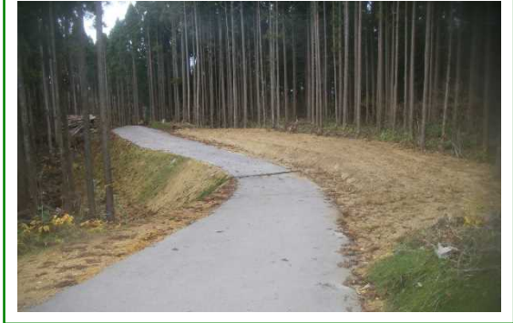
林道（林業専用道）新設
