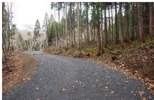
林道（林業専用道）新設
