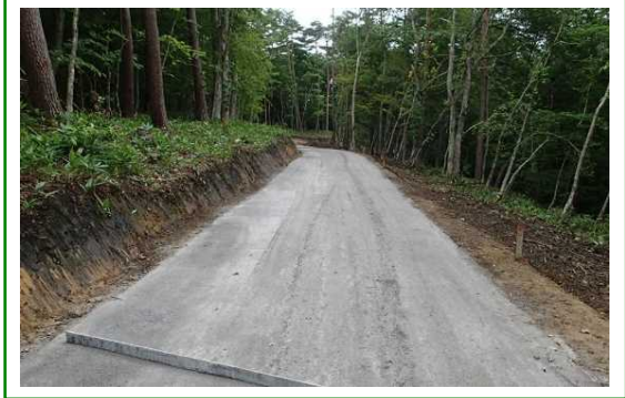
林道（林業専用道）新設
