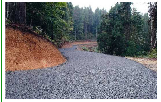
林道（林業専用道）新設
