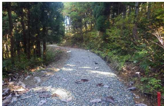
林道（林業専用道）新設
