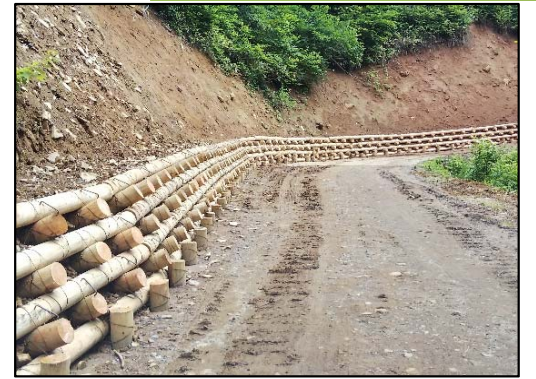
間伐材等を使用した丸太積工
