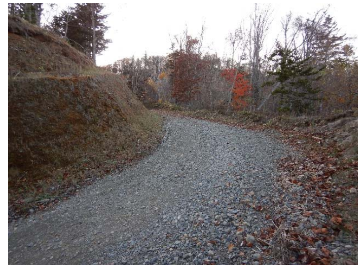
カンカン林道 新設工事
