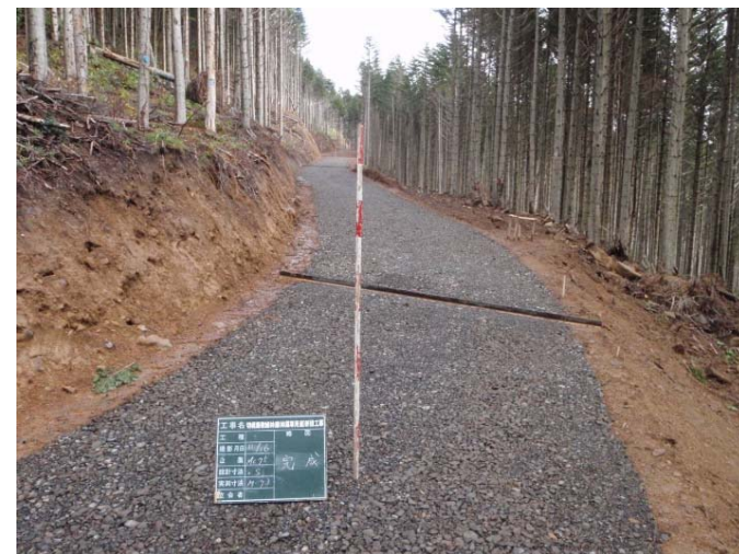
切梶島歌林道 新設工事
