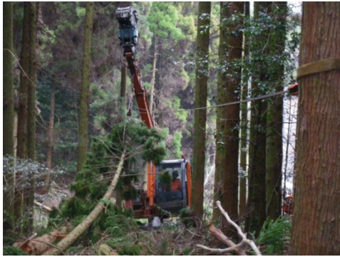
木材搬出路(作業道)
