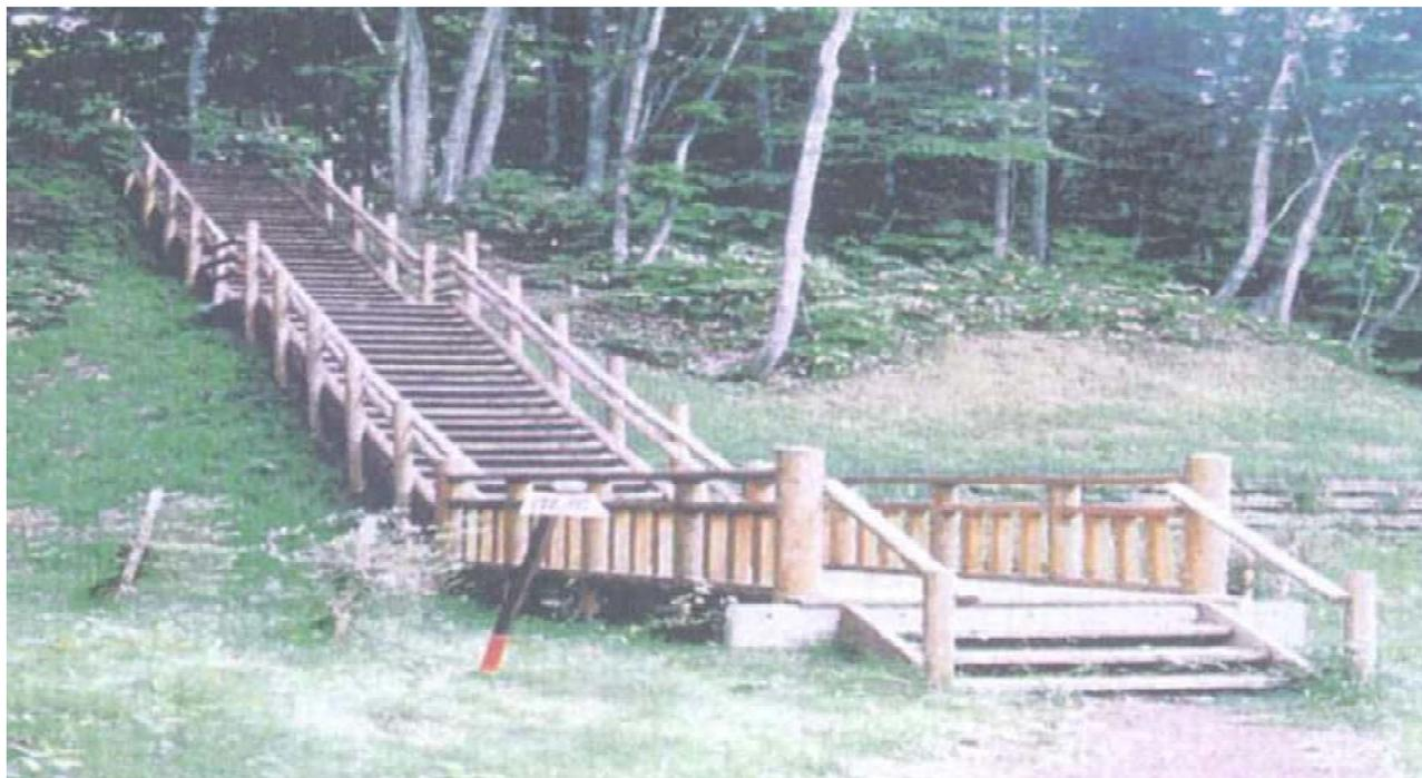
平成9年施工／カラマツ間伐材使用  $B = 1.5\text{m}$   $0.68 \text{ m}^3 / 1\text{基}$  (3.65m) 当たり
