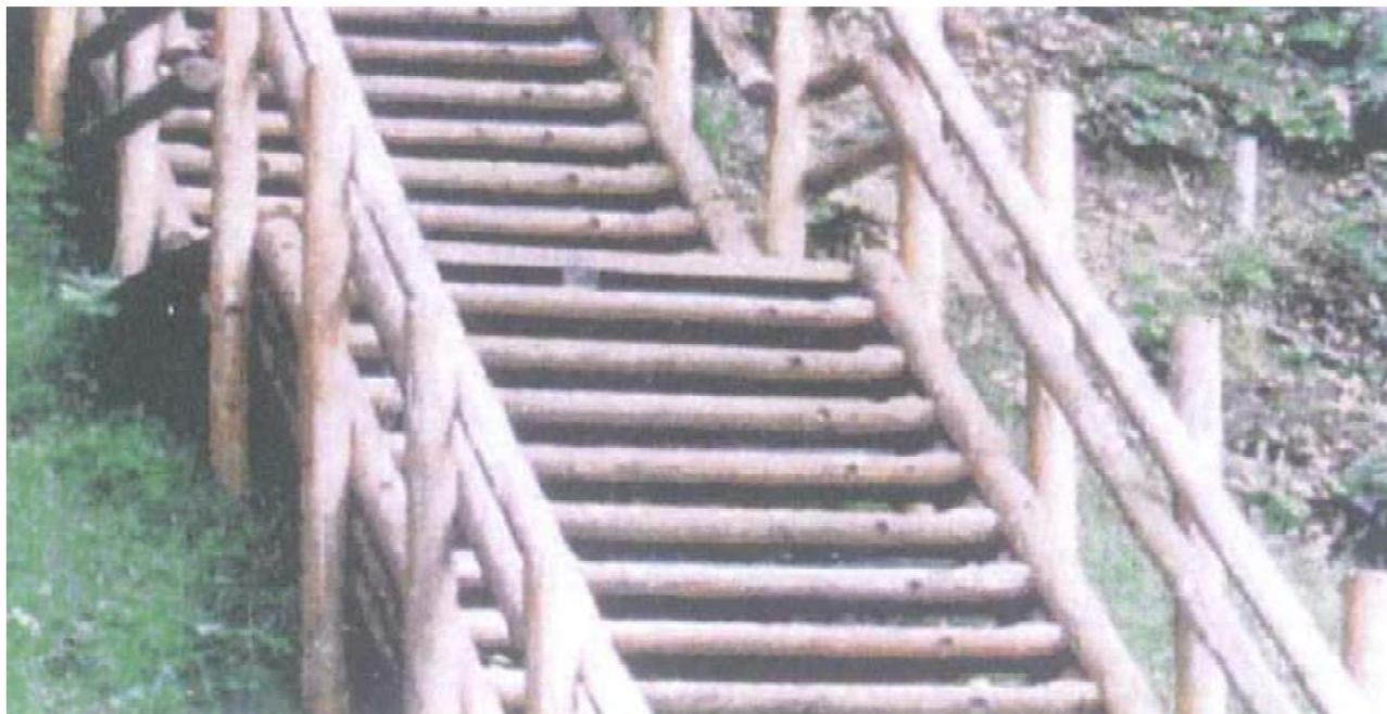
使用部材：支柱・桁  $\phi = 12\text{cm}$  踏丸太  $\phi = 12\text{cm}$  太鼓落 根枷  $\phi = 10\text{cm}$  ボルト  $\phi = 13\text{mm}$
