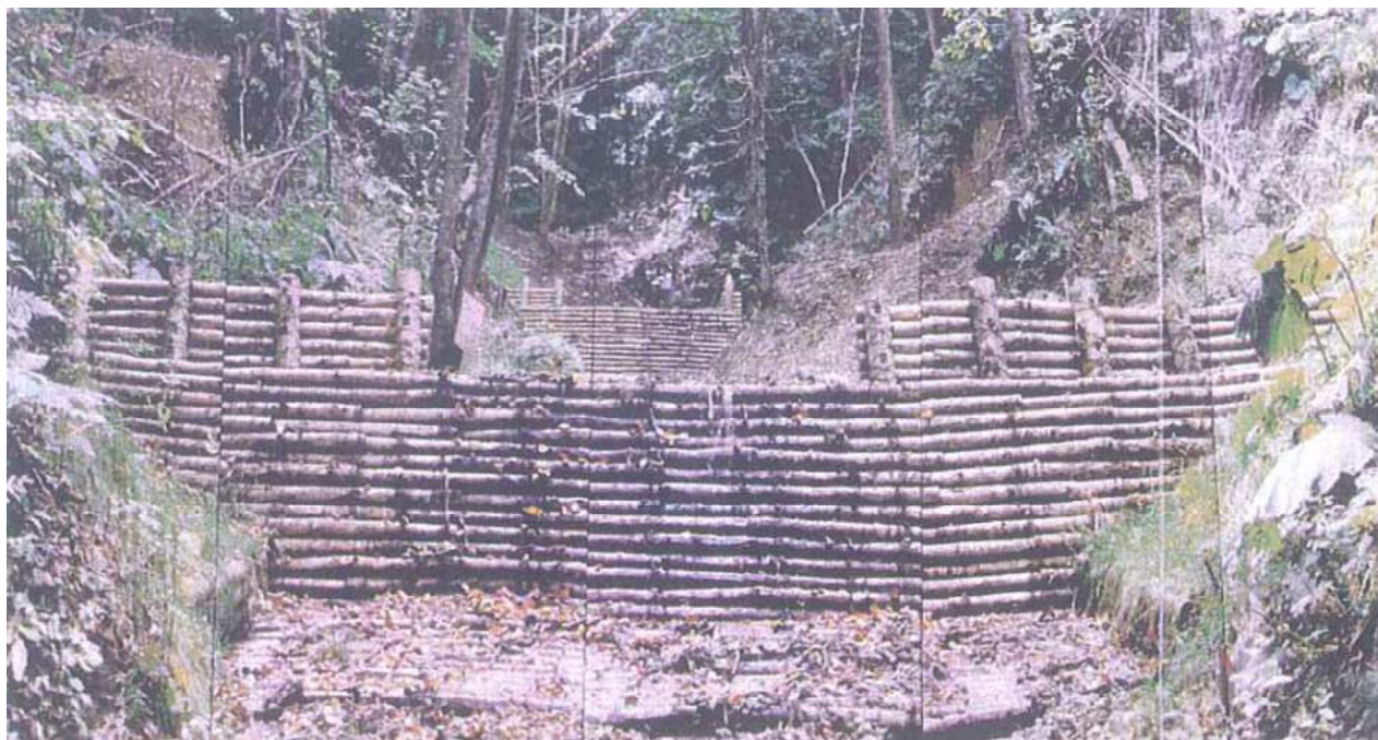
治山ダム（昭和 62 年施工）／カラマツ間伐材使用 1 基当たり 14.55 m 3
