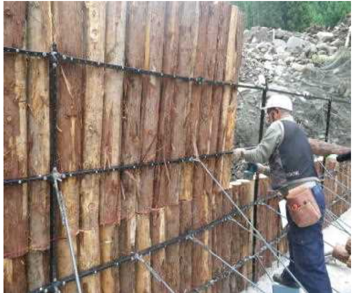
間伐材取付状況
