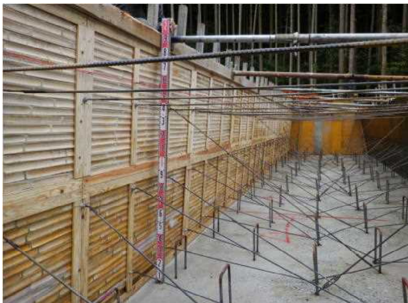
組立状況（内側）
