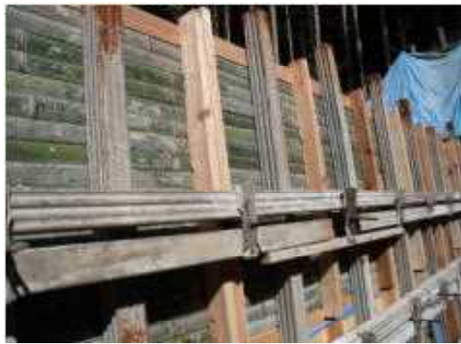
組立状況（外側）
