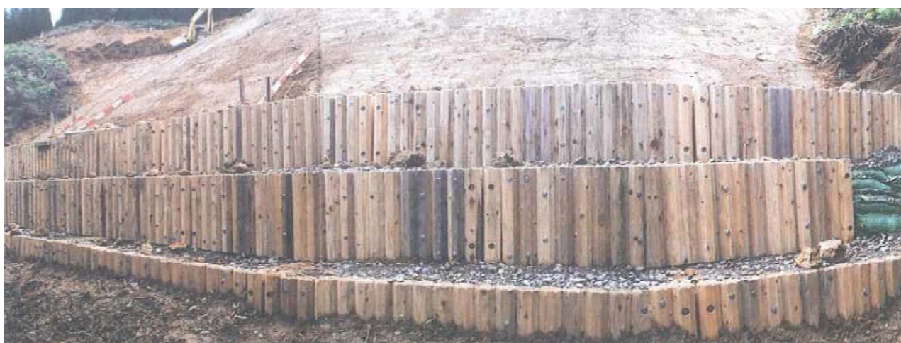
平成 11 年度施工／スギ間伐材 12.0m 3 使用 H=0.5m L=1.80m W=1.20m
