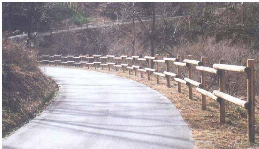
平成 11 年度施工／L=116m スギ間伐材（丸棒加工） 4 m 3
