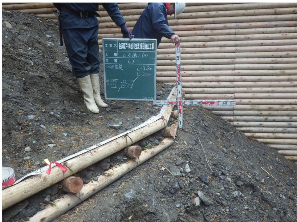
溪間工の間詰の緑化の基礎工として使用した丸太筋工（A）（2段積）
