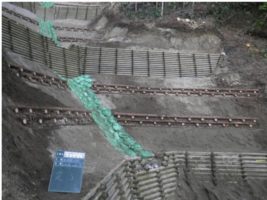
山腹工の筋工として使用した丸太筋工（B）（3段積）
