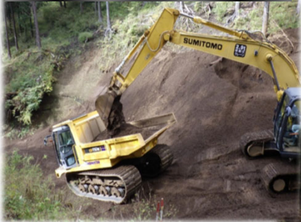
不整地運搬車への土砂積込
