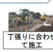
検測と施工を繰 り返して整形
