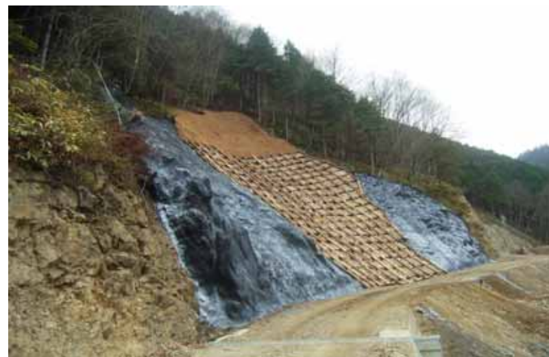
完成後の状況
