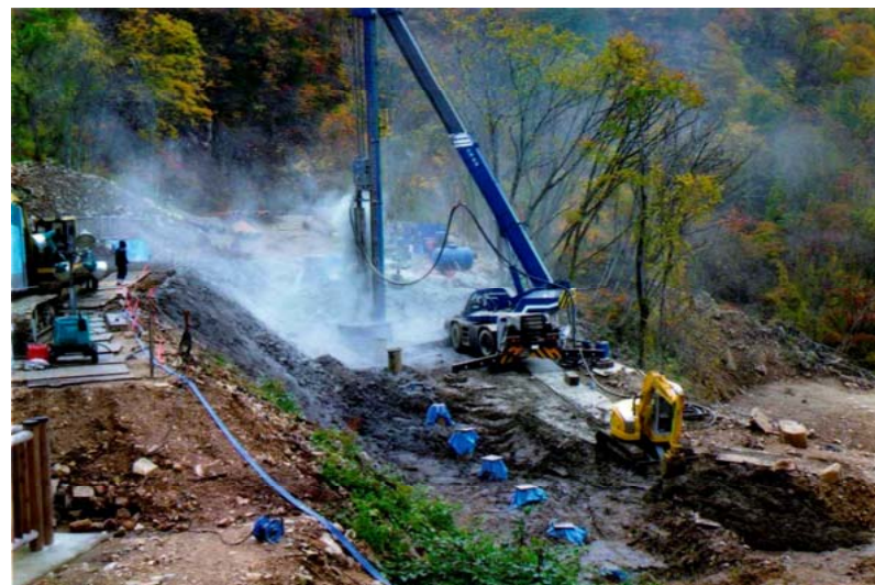
ダウンザホールハンマ工での施工状況
