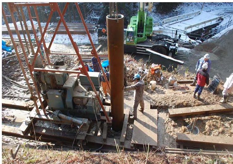
大口径ボーリング工での施工状況
