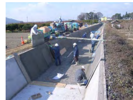
【表面被覆作業状況】
