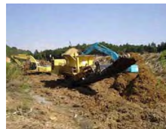
木材チップ化作業状況
