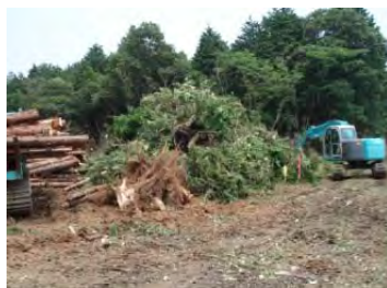
伐採作業の実施
