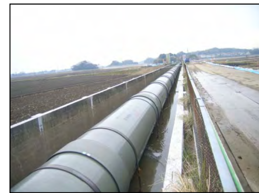
【農業用水管の水路内設置】
