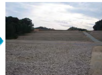
法面保護完了
