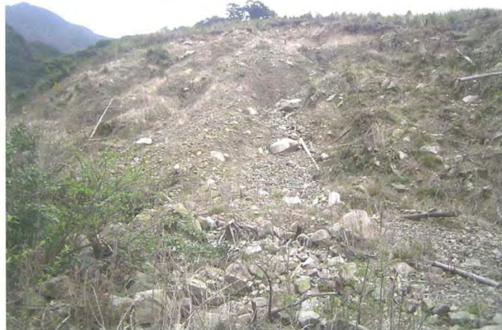
施工前の状況
