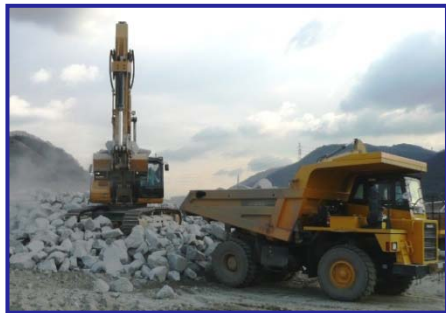
仮置き場からの積み込み
