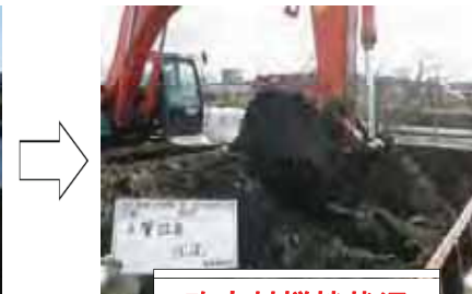
改良材攪拌状況
