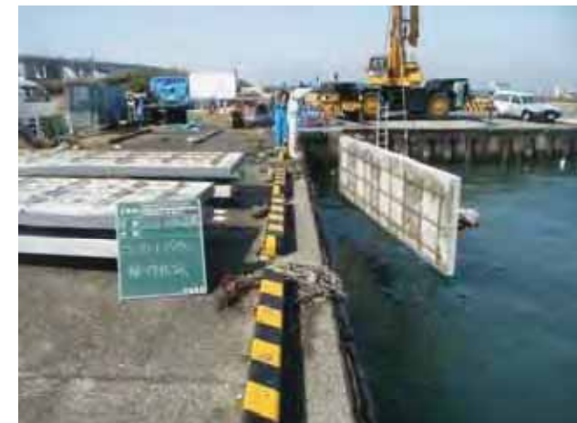
防食工作業状況
