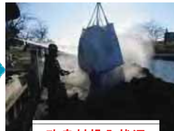
改良材投入状況
