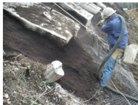
植生基材の吹付け
