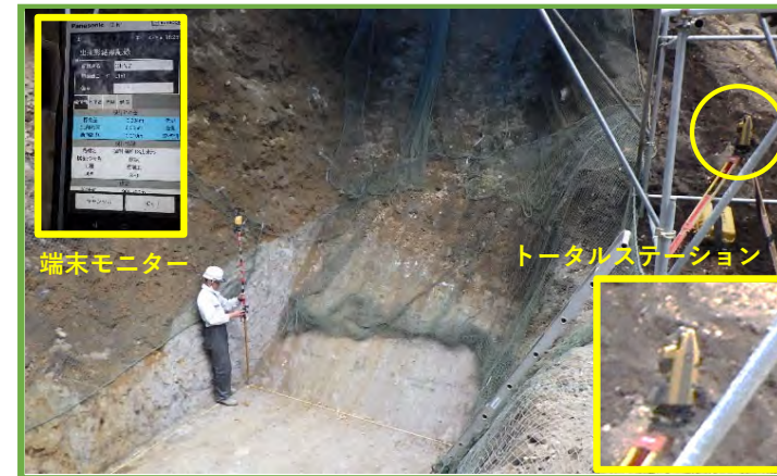
掘削工出来形計測
