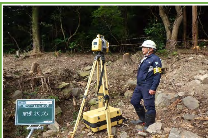
測量状況写真
