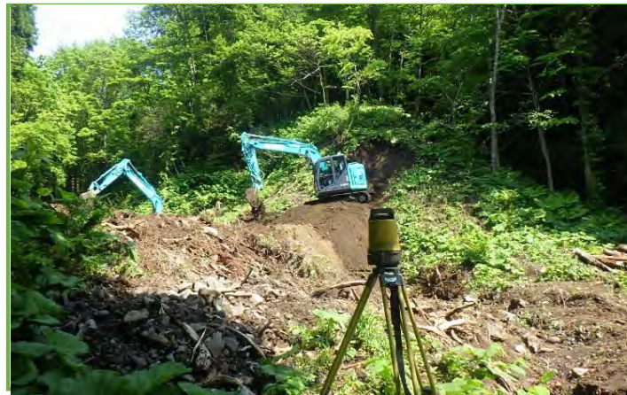
MGバックホウによる掘削作業
