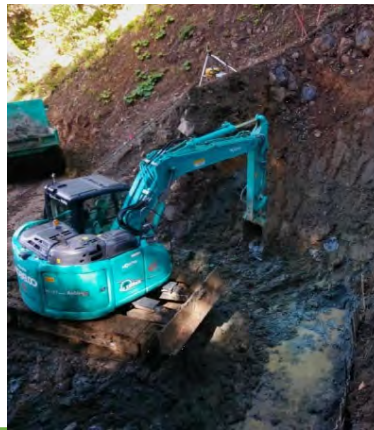
掘削作業状況
