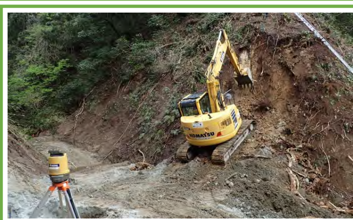
MGバックホウによる掘削作業
