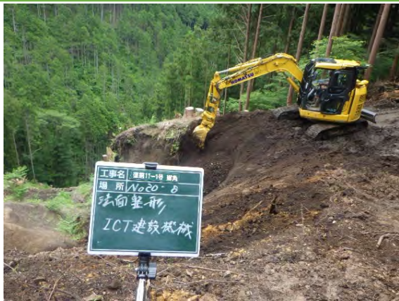
MGバックホウによる掘削（法切工）状況
