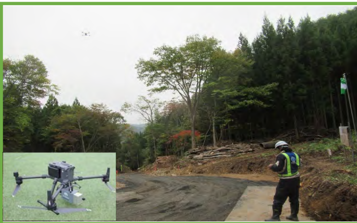
UAVによる起工測量状況
