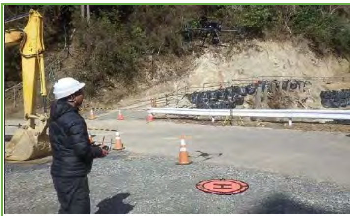
ドローンによる測量
