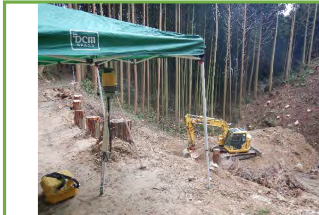
MGバックホウによる掘削
