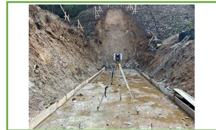
床掘出来形確認
