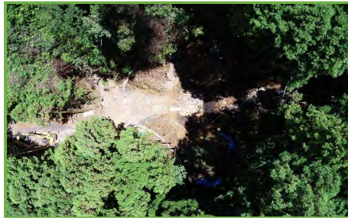
無人航空機による施工箇所撮影
