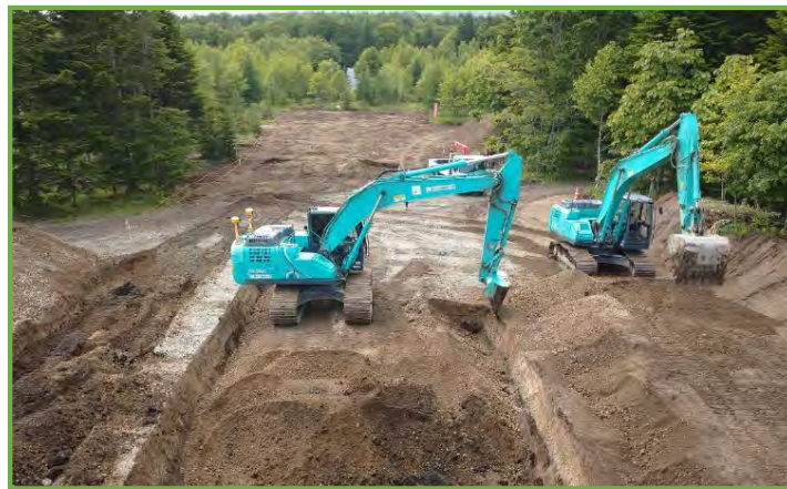
ICT建機（MCバックホウ）施工中
