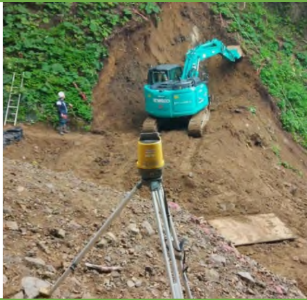
掘削作業状況
