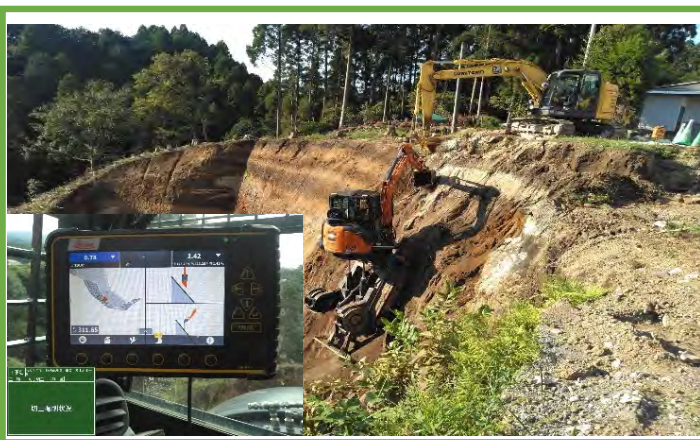
MGバックホウによる施工
