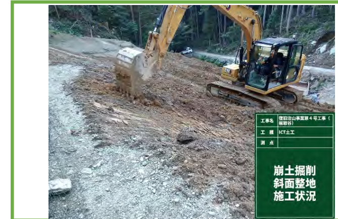
ICT土工 掘削・法面整形施工状況
