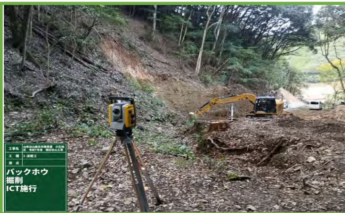
MCバックホウによる掘削作業
