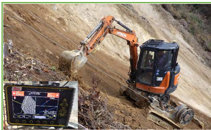
マシンガイダンスによる法面掘削
