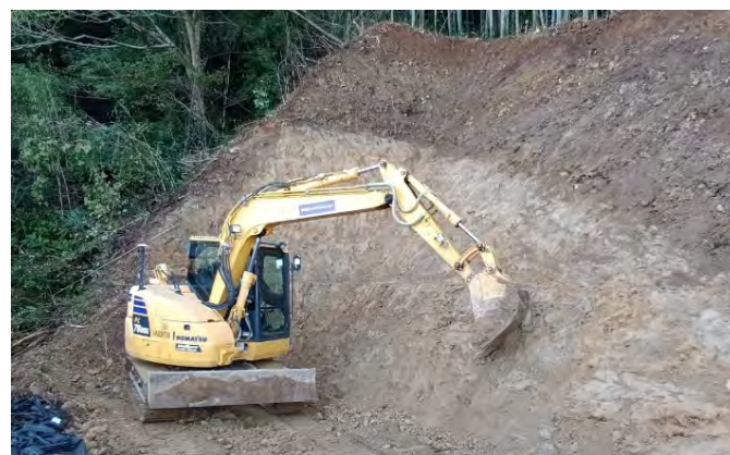
ICT法面整形状況
