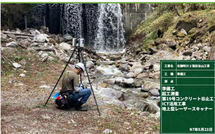
地上型レーザーを用いた起工測量
