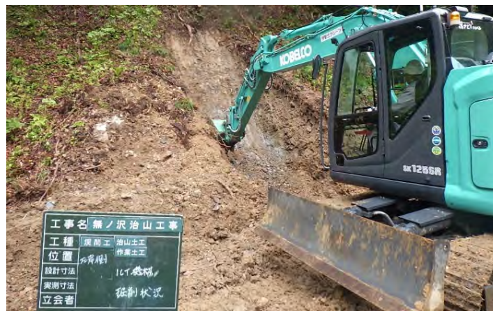
MGバックホウによる掘削作業
