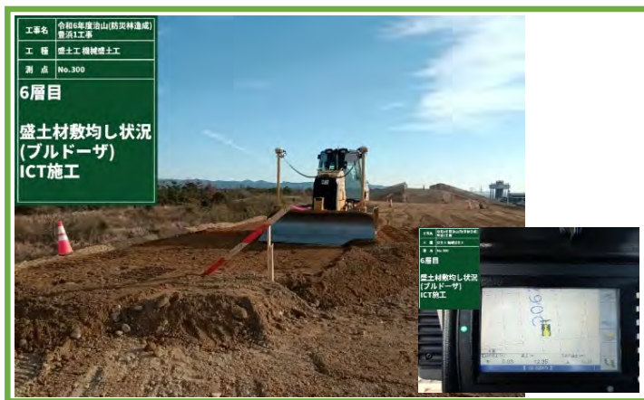
MCブルドーザーによる敷き均し
