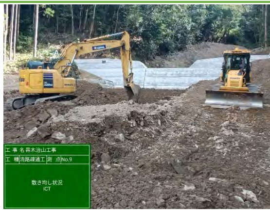
施工状況（盛土・法面整形）
