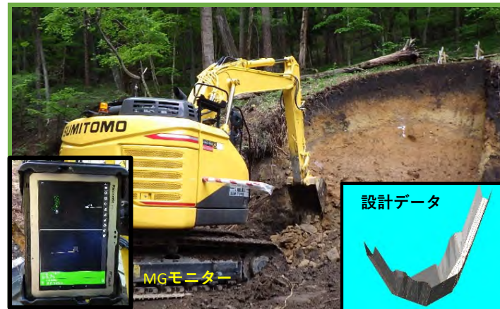
MGバックハウによる掘削
