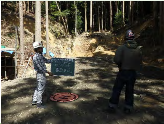
UAV出来形測量撮影状況
