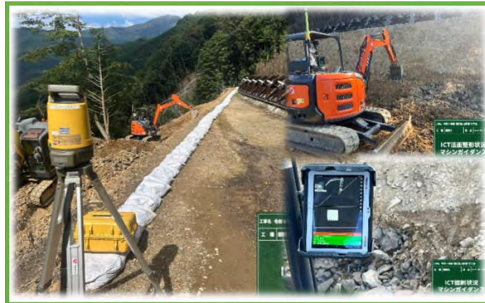
杭ナビショベルによるICT施工
