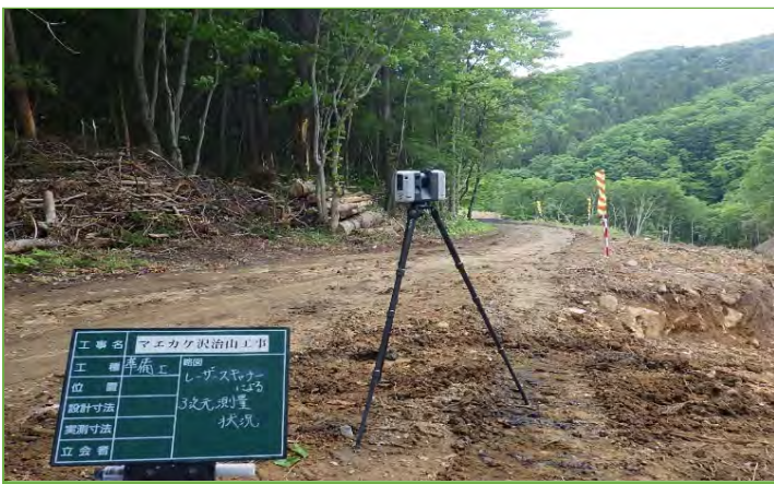
3次元起工測量実施状況
