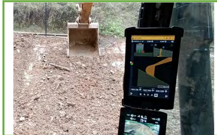
ICT土工施工時モニター
