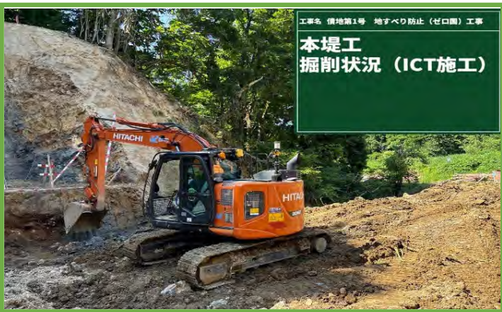
MGバックホウによる掘削作業
