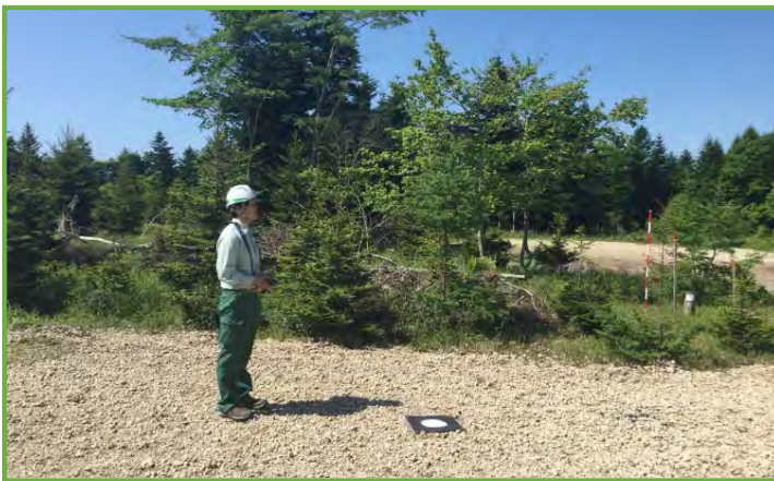
UAVによる起工測量
