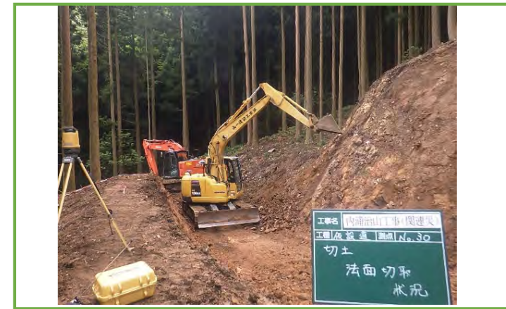
ICT建機施工
