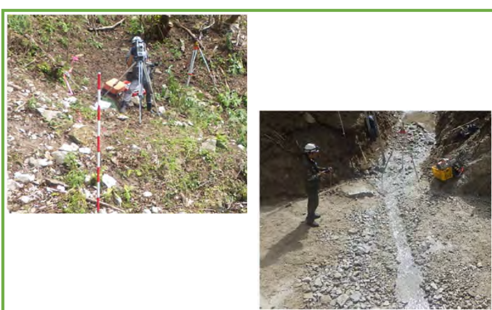
TLSによる測量
