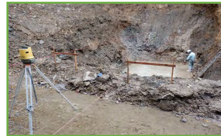
杭打ちナビによる測量状況
