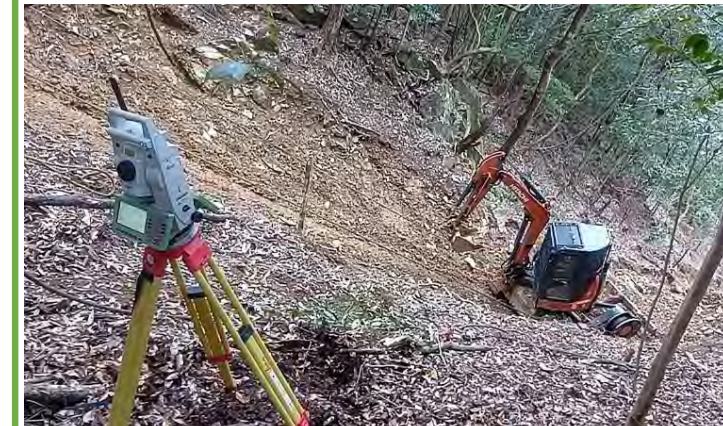
ICT掘削作業
