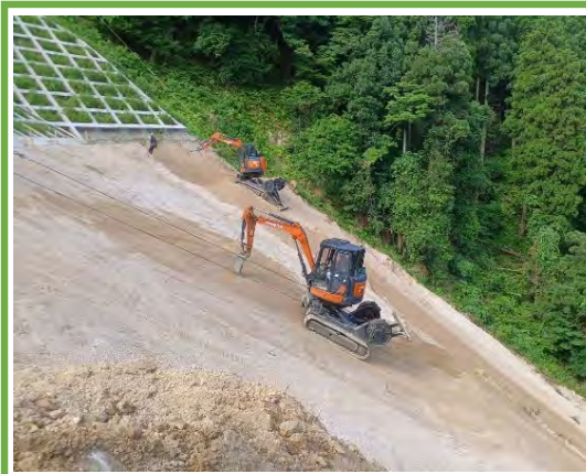
MG法面掘削機による掘削作業
