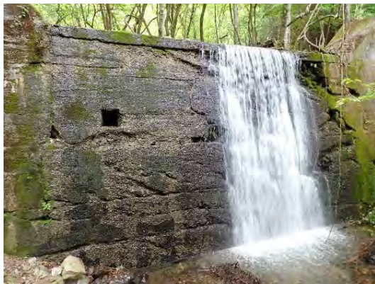
補修対象施設
