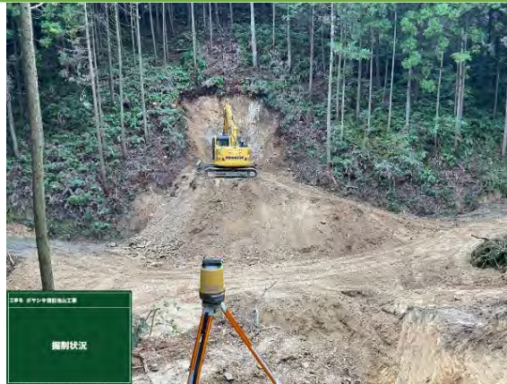
MGバックホウによる掘削
