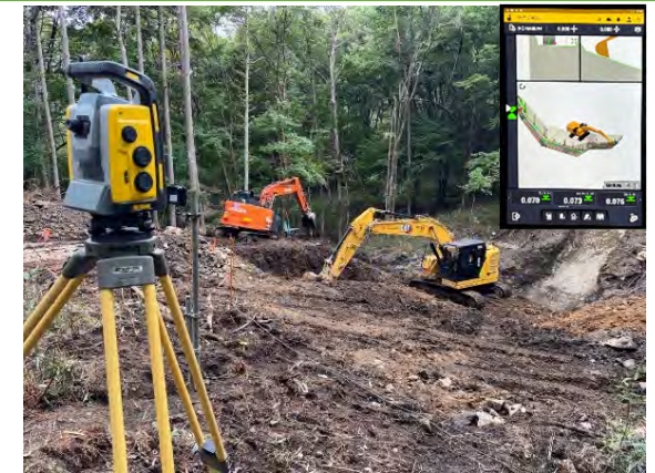
MG・MCバックホウによる掘削
