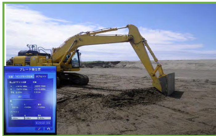
MCバックホウによる掘削
