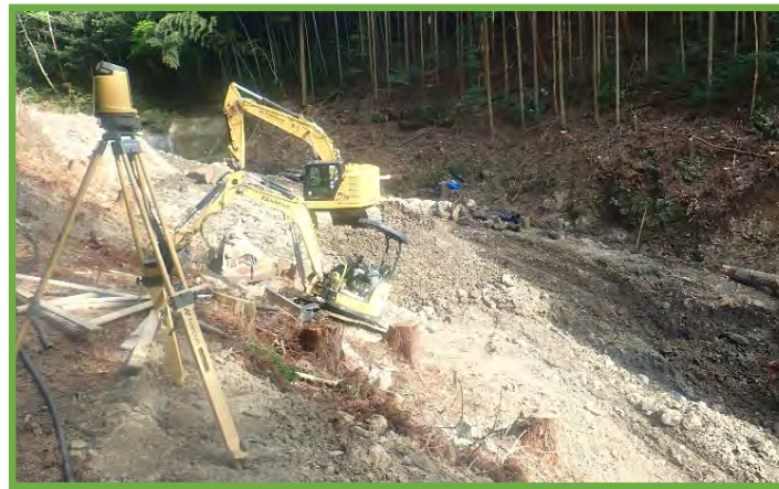
杭ナビ設置状況
