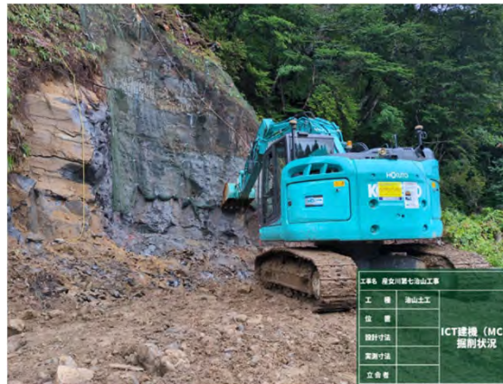
I C T建機による掘削状況
