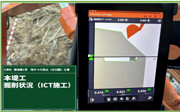
タブレット端末による掘削
