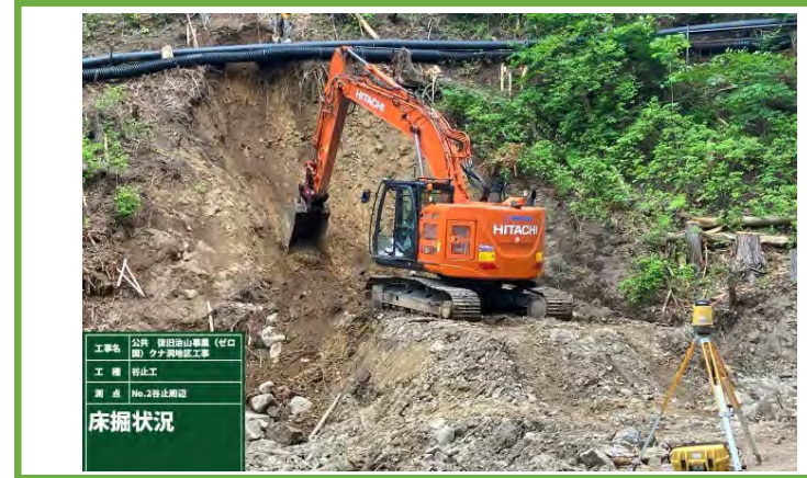
谷止工の掘削状況
