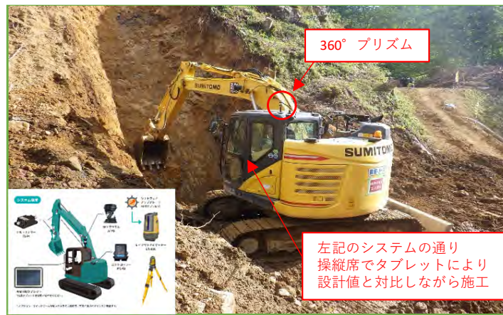
谷止工 掘削状況
