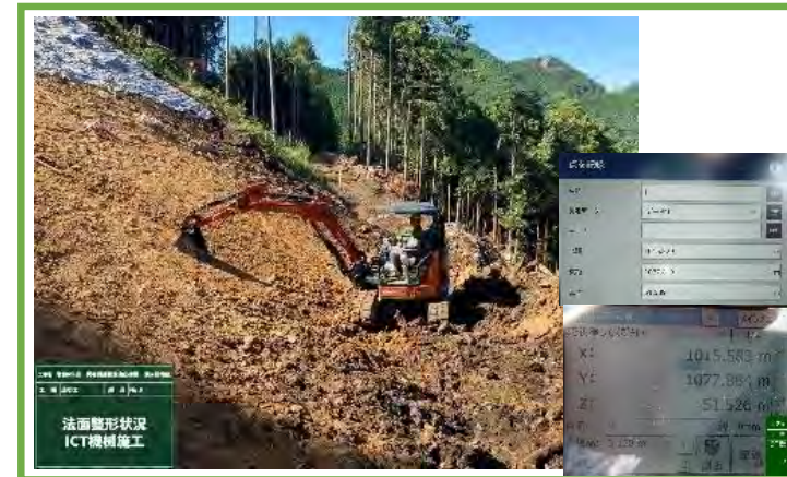
ICT (MG) バックホウによる法切
