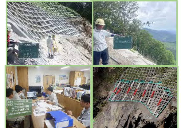
地上型レーザースキャナー及び、UAV測量による 出来形管理、3次元データの納品・検査
