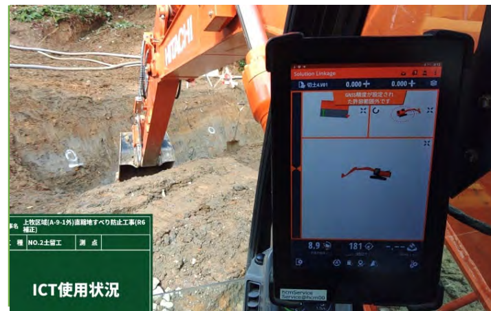
掘削状況 (ガイダンス)
