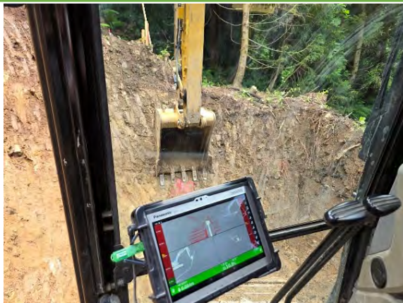
MGバックホウによる掘削
