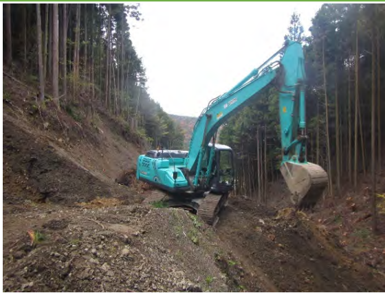
MGバックホウによる掘削
