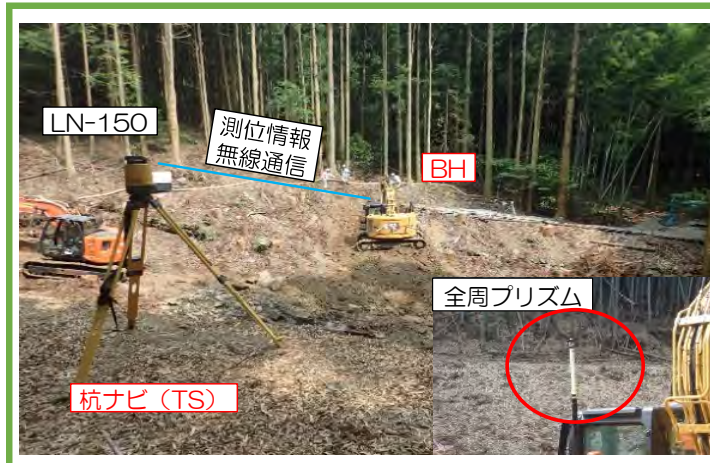
杭ナビから重機へ設計データを転送し、建機内モニターを確認しながら掘削している状況
