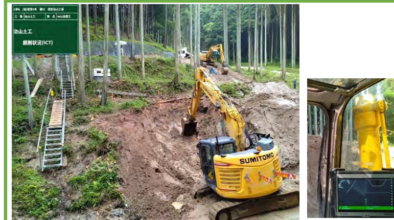
MGバックホウによる掘削 車内モニター(右)
