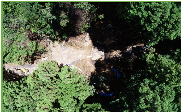
無人航空機による施工箇所撮影
