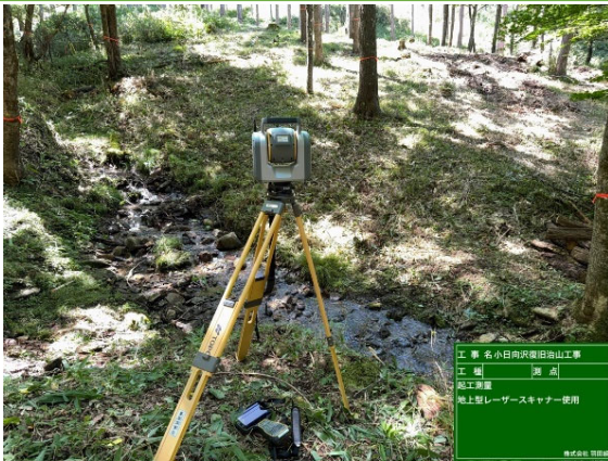
TLSによる起工測量
