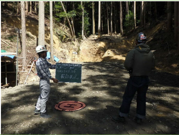
UAV出来形測量撮影状況
