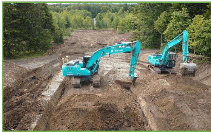
ICT建機（MCバックホウ）施工中
