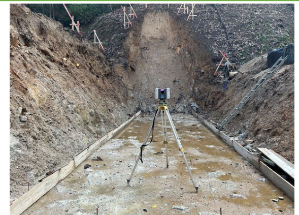
床掘出来形確認
