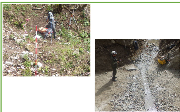
TLSによる測量
