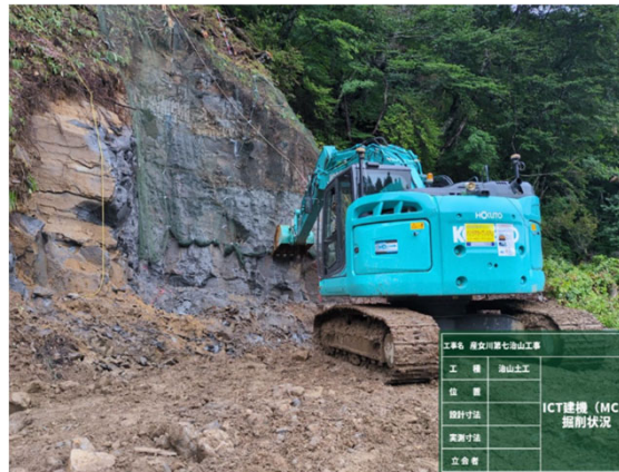
I C T建機による掘削状況
