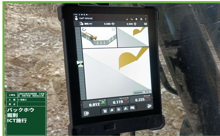
ICT建機掘削（運転席モニター）
