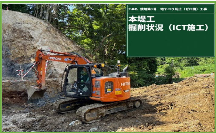
MGバックホウによる掘削作業
