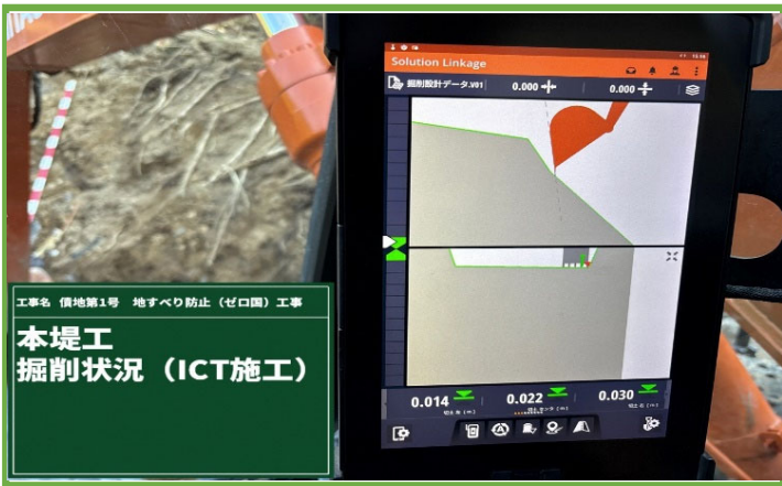
タブレット端末による掘削
