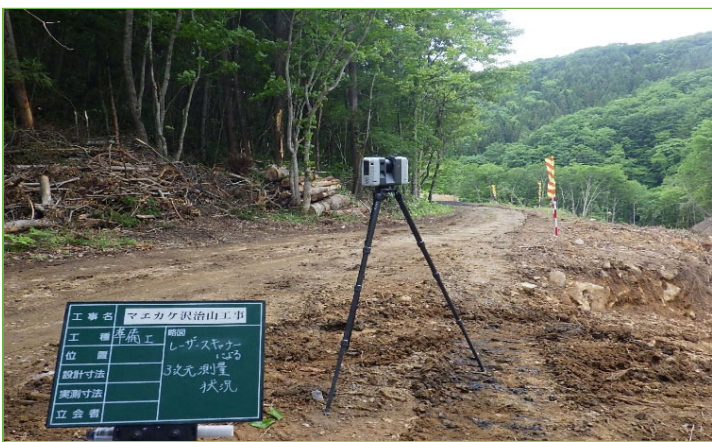
3次元起工測量実施状況
