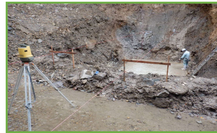
杭打ちナビによる測量状況
