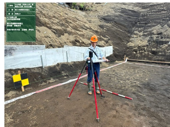
鋼製柵床固工 床付面の3次元出来形管理
