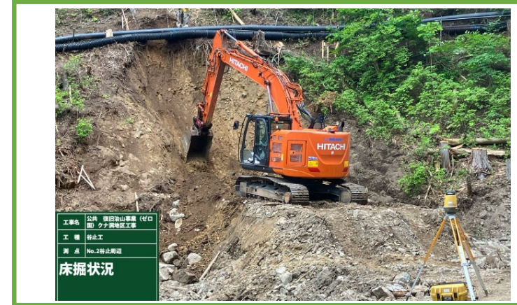
谷止工の掘削状況
