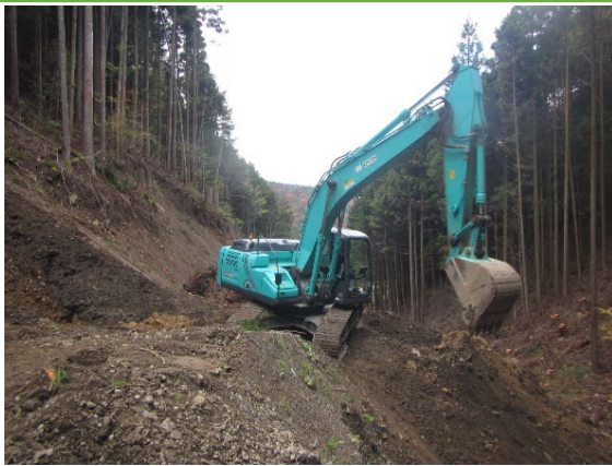
MGバックホウによる掘削
