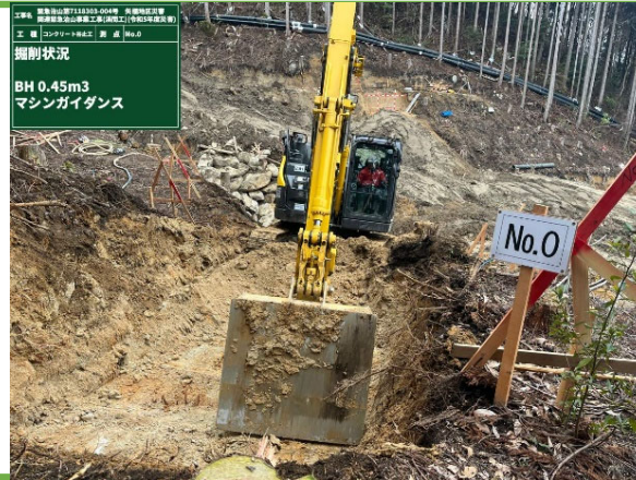
MGバックホウによる施工
