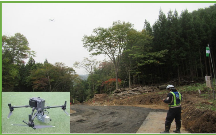
UAVによる起工測量状況
