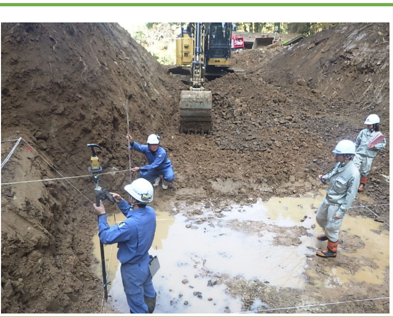
自動追尾TSによる床掘確認
