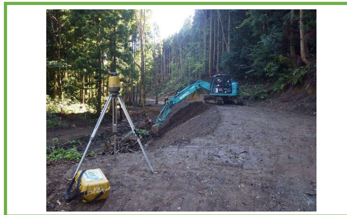
MGバックホウによる法面整形作業
