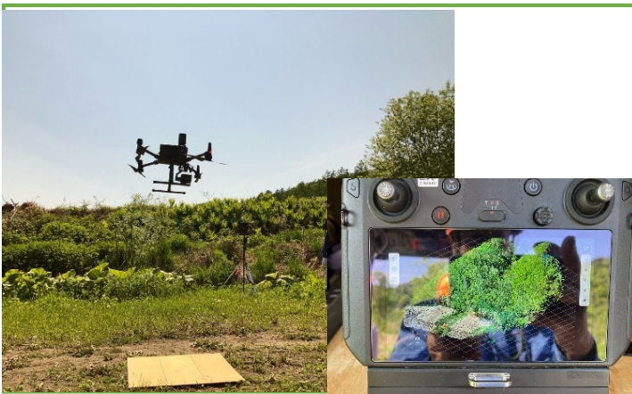
UAVによる起工測量
