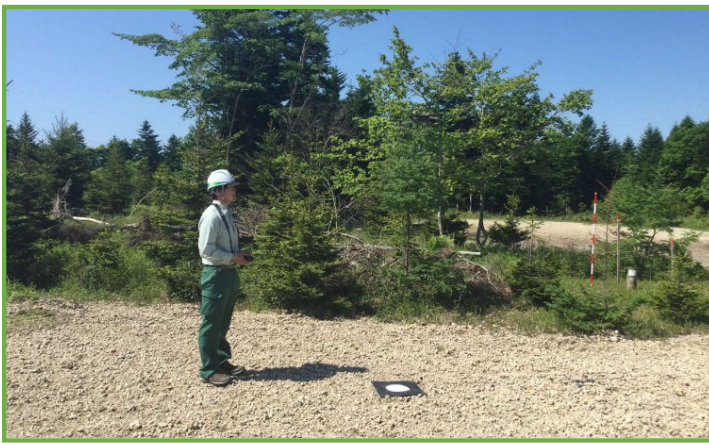
UAVによる起工測量
