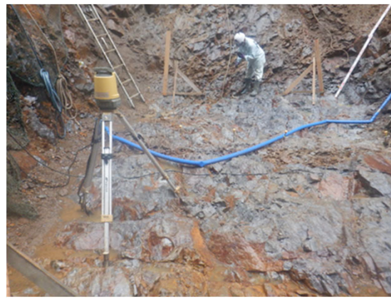
床付け出来形検測状況
