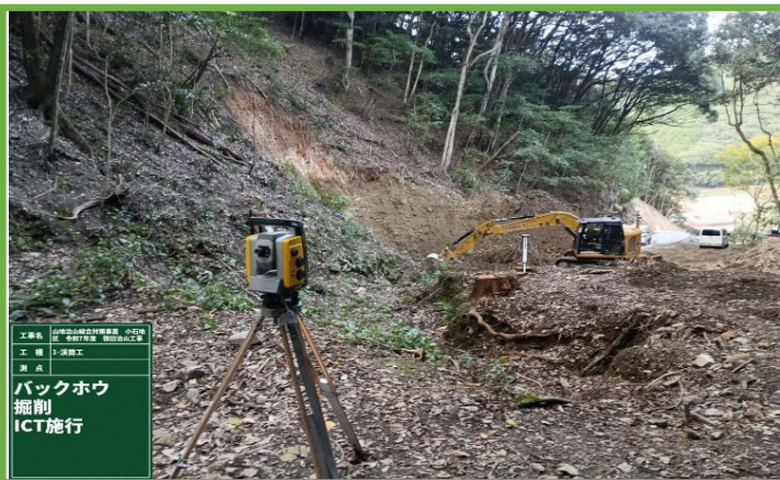
MCバックホウによる掘削作業
