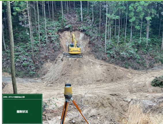
MGバックホウによる掘削
