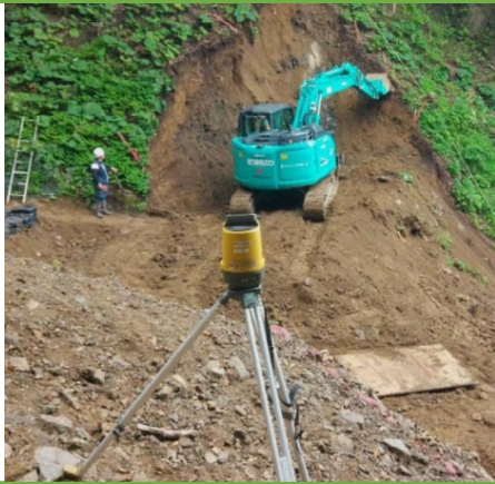
掘削作業状況
