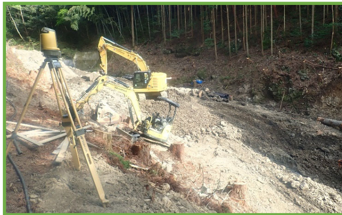
杭ナビ設置状況
