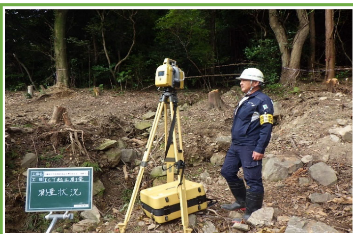
測量状況写真
