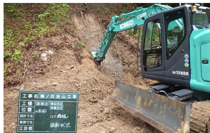
MGバックホウによる掘削作業
