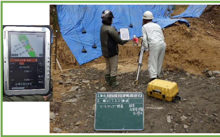
ヒートマップ検査(確認検査)
