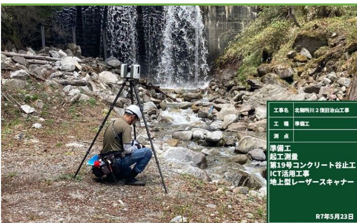
地上型レーザーを用いた起工測量
