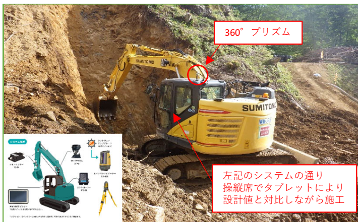
谷止工 掘削状況
