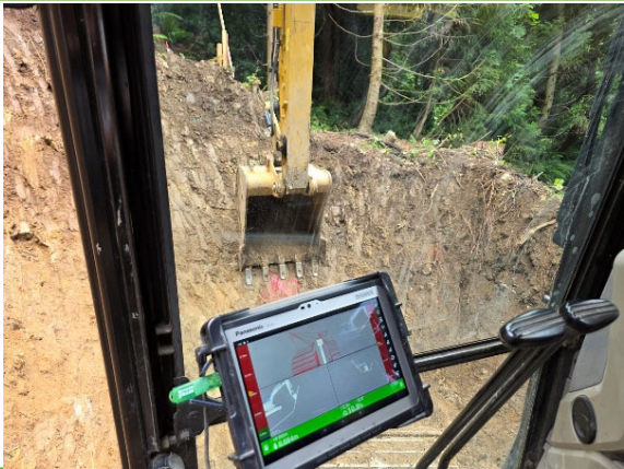
MGバックホウによる掘削
