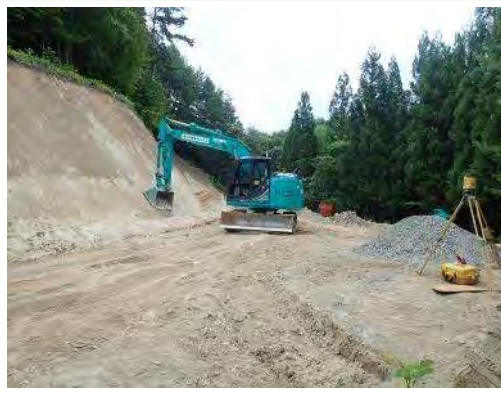
RTK-GNSS装着バックホウによる掘削状況
