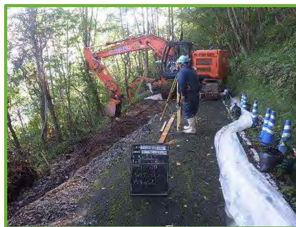
ICTバックホウ 掘削状況
