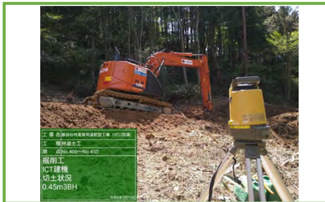
MC・MG付きバックホーによる掘削(切土)
