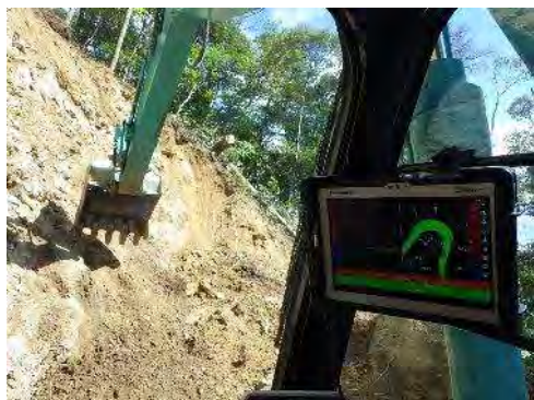
ICTの機械施工
