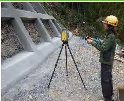
レーザースキャナー出来形状況
