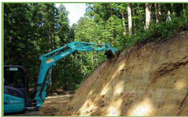
MGバックホウによる掘削状況
