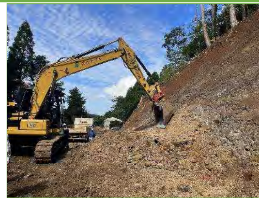
MGバックホウ掘削状況
