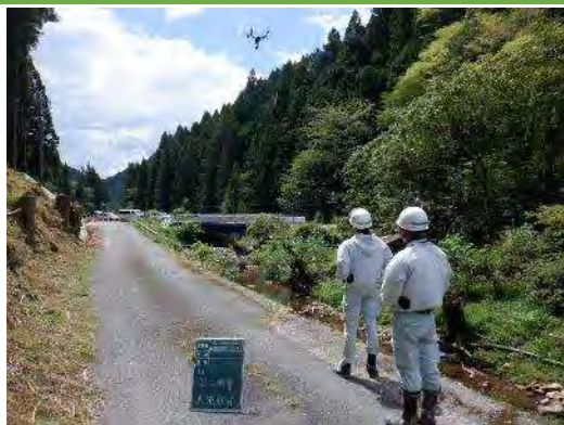
UAVによる3次元起工測量
