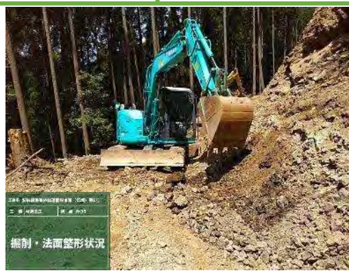
MGバックホウによる掘削（床掘）
