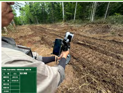
TLSを用いた起工測量の実施
