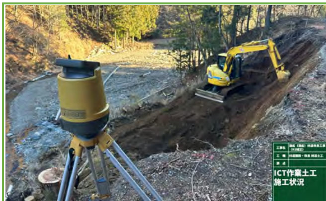
0.25m3BH_PC78US、杭ナビ LN-150を活用した床掘
