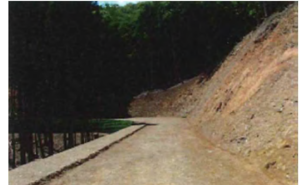
切土法面・路体・補強土壁の出来栄え
