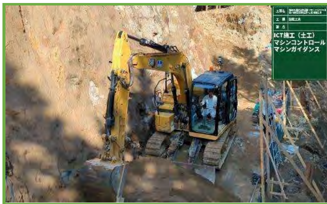
MCバックホウによる掘削
