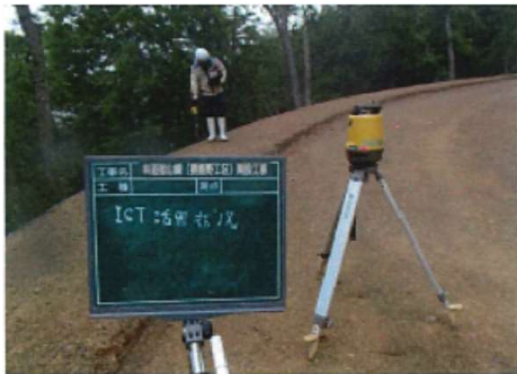
杭ナビによる計画位置、高さなどを常時確認しながら施工
