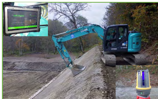
MGバックホウによる土工法面整形
