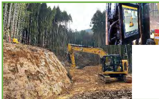
MC/MG法面整形状況及び車載モニター
