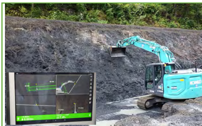
MGバックホウによる床掘
