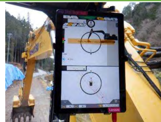
3次元設計データによる土工の実施
