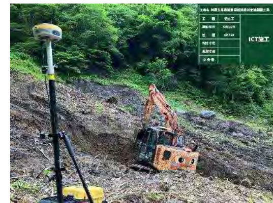
MG・MCバックホウによる切土工施工
