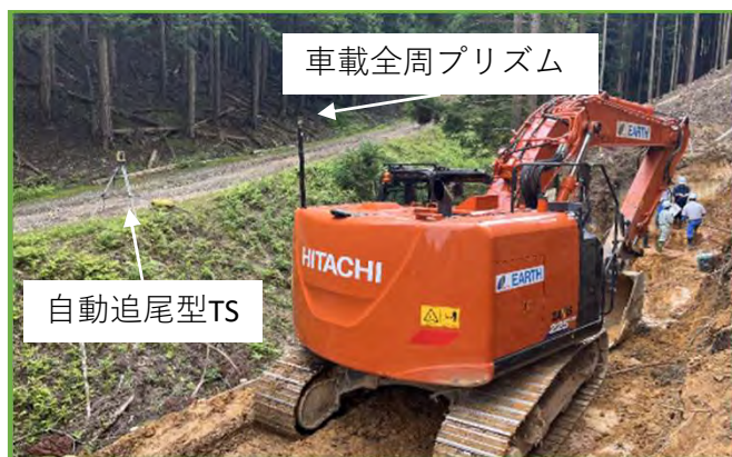
自動追尾型TSを使用した マシンガイダンス付きバックホウ
