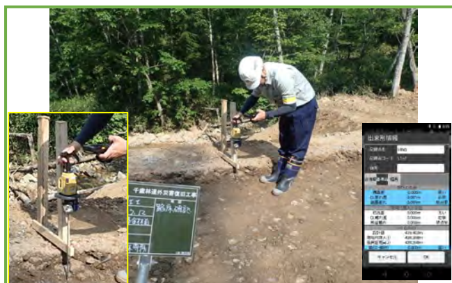
出来形測定状況(ワンマン観測)
