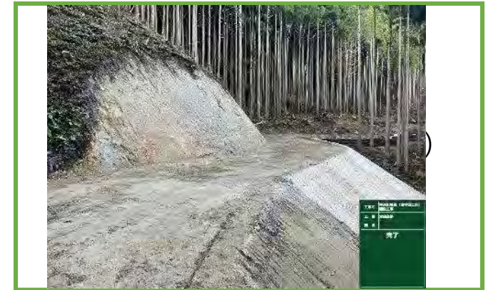
掘削・盛土法面出来栄
