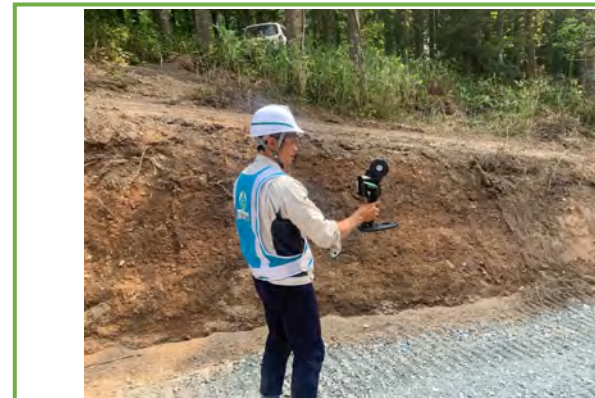
ハンドスキャナー出来形点群計測状況
