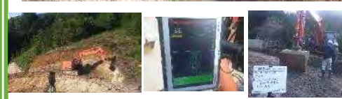
3DMGバックホウによる掘削・法面整形 刃先の精度確認
