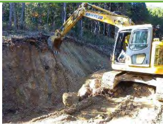
MG(マシンガイダンス)バックホウによる切土法面整形
