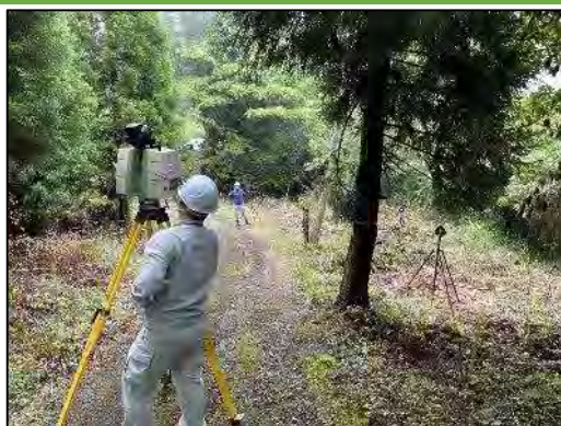
TLSによる3次元起工測量
