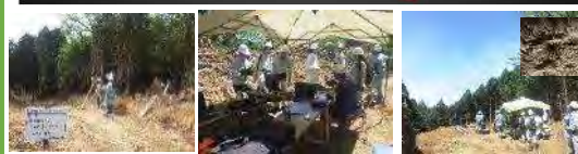
TLS及びUAVレーザーによる3次元起工測量 発注者、地元同業者との合同説明会の実施
