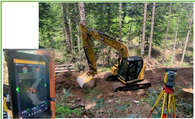
MCバックホウによる掘削状況
