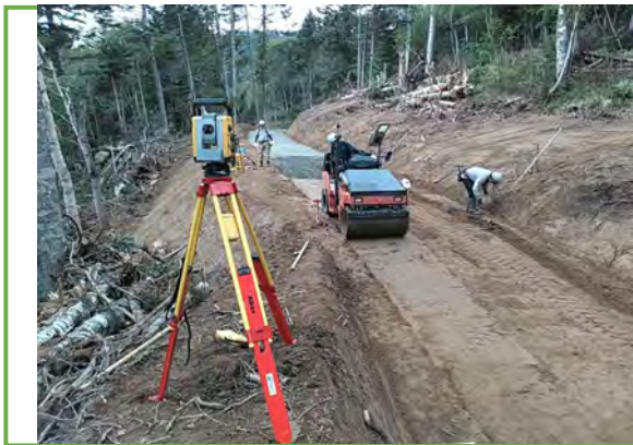
TSによる転圧回数確認状況
