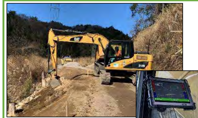
MGバックホウによる法面整形 運転席モニター
