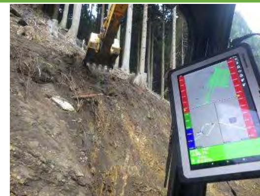
施工状況写真
