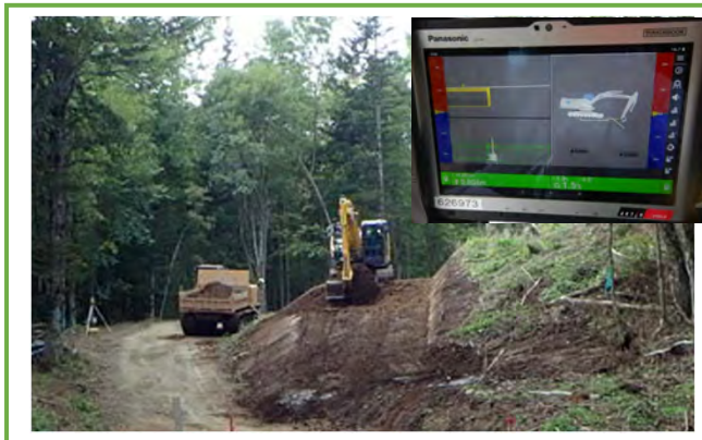
MGバックホウによる掘削（切土）
