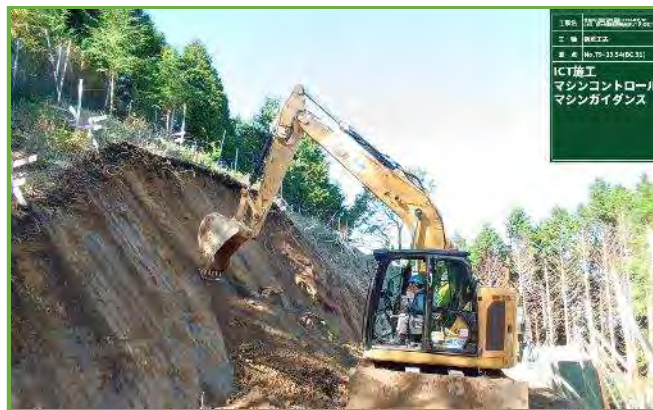
均一な掘削法面を実現
