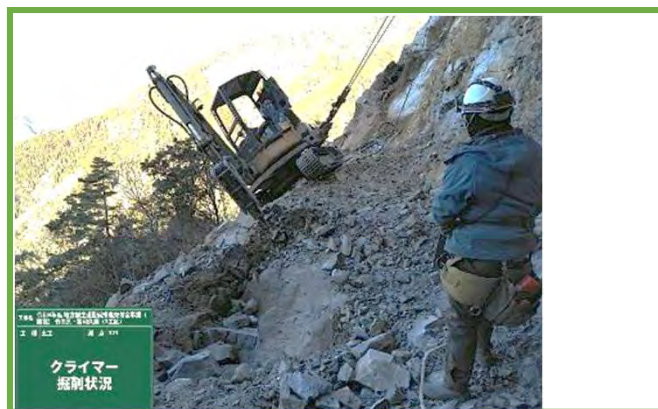
無人掘削機による土工
