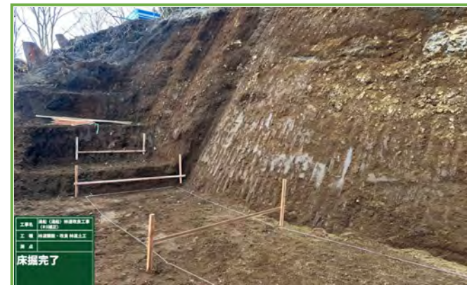
床掘完了状況
