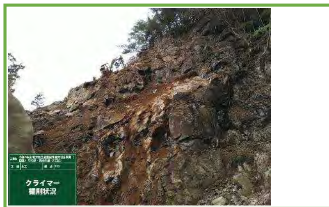
無人掘削機による土工
