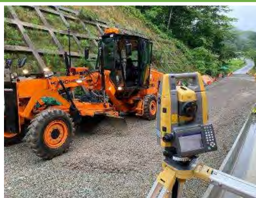
TSにより高さ・位置情報を観測・追尾し、得た情報を重機に送信してブレードを制御する
