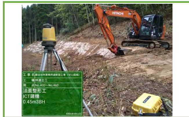
MC・MG付きバックホーによる掘削(法面整形)
