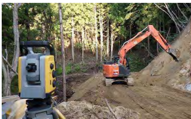
MGバックホウによる施工
