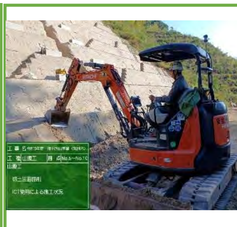
掘削、法面整形
