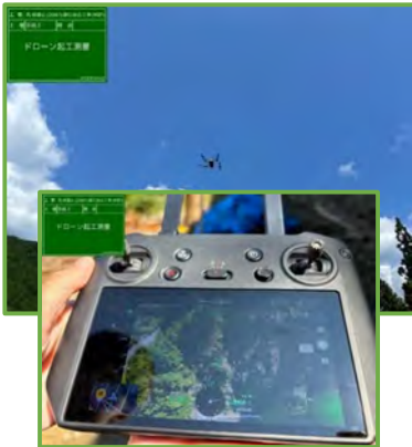
UAVによる起工測量状況
