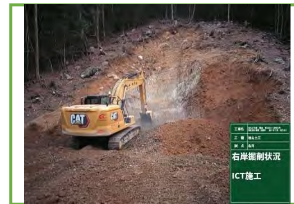
ICT建機による掘削
