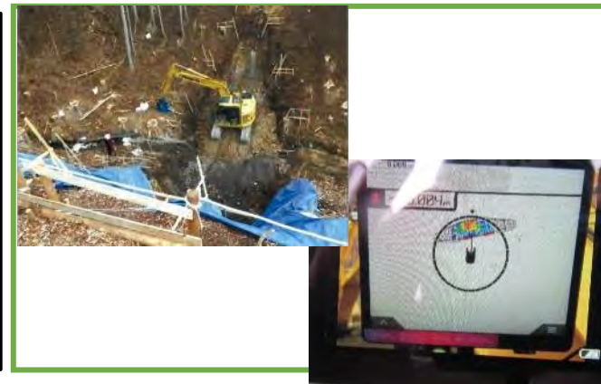
ICT機械施工
