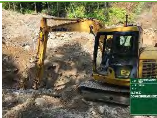
MGバックホウによる掘削
