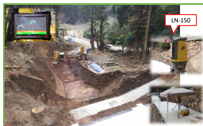
ICT機械による掘削（LN-150使用）
