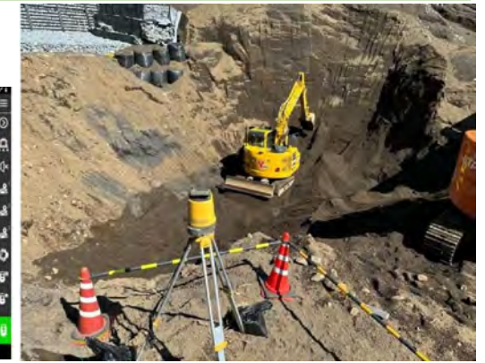
ICT建設機械による掘削
