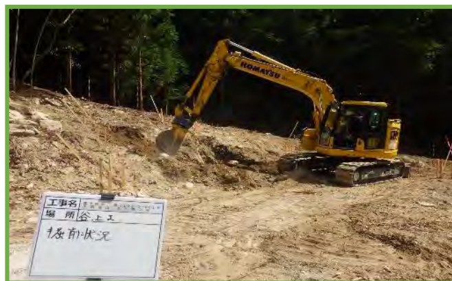
MGバックホウによる掘削作業
