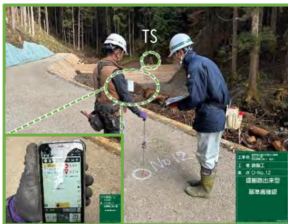
TS(光波方式) による出来形管理状況
