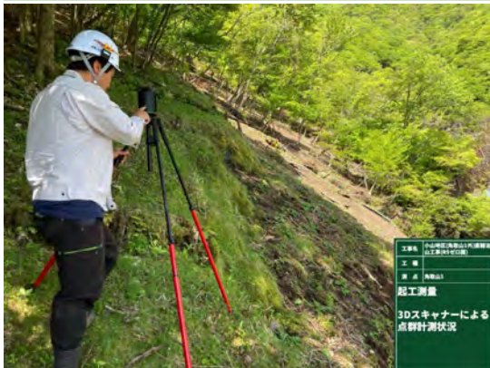
3Dレーザースキャナーによる測量
