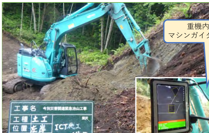
MGバックホウによる掘削作業
