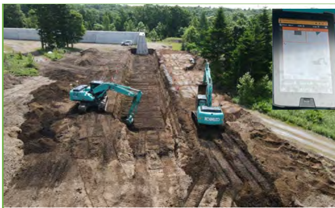
ICT建機（MCバックホウ）施工中
