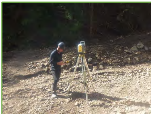
TLSによる起工測量状況
