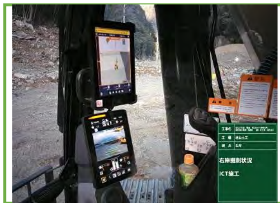
ICT施工時 モニター
