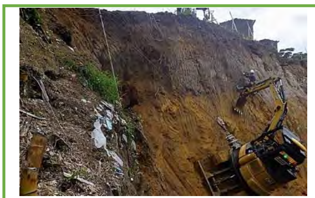
ICT建機(無人)による斜面掘削
