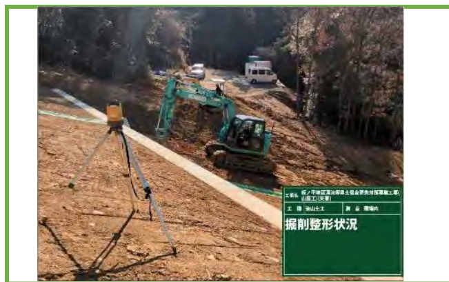
MGバックホウによる施工
