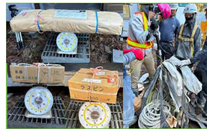
運搬資材 総重量約1.5t (植生マット16kg×80個、アンカー25kg×5箱、止釘13kg×6箱)
