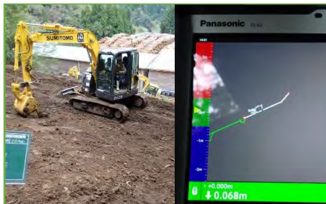
MGバックホウによる掘削工及び法面整形
