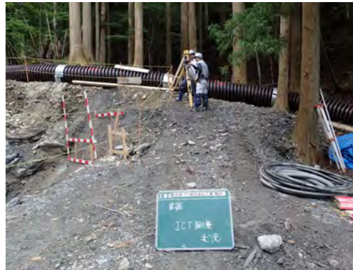
床堀後の地上レーザーによる測量
