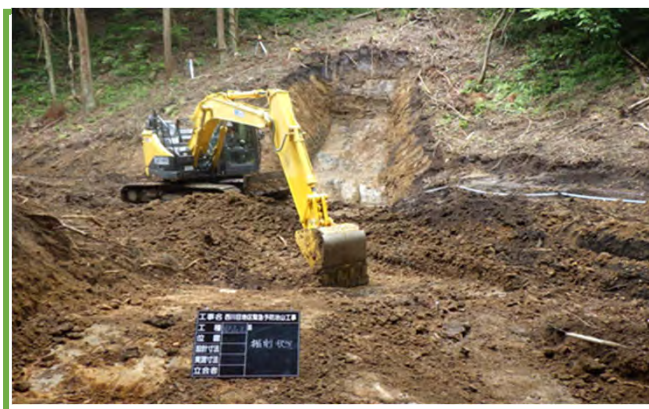
MGバックホウによる掘削
