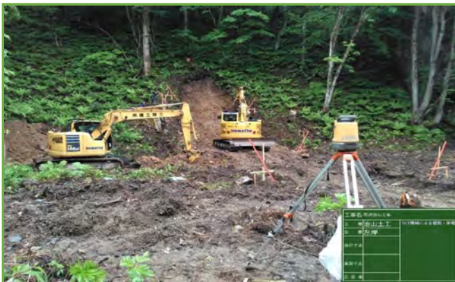
杭ナビショベルでの床堀状況
