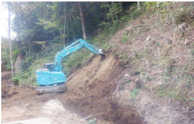
MGバックホウによる掘削作業
