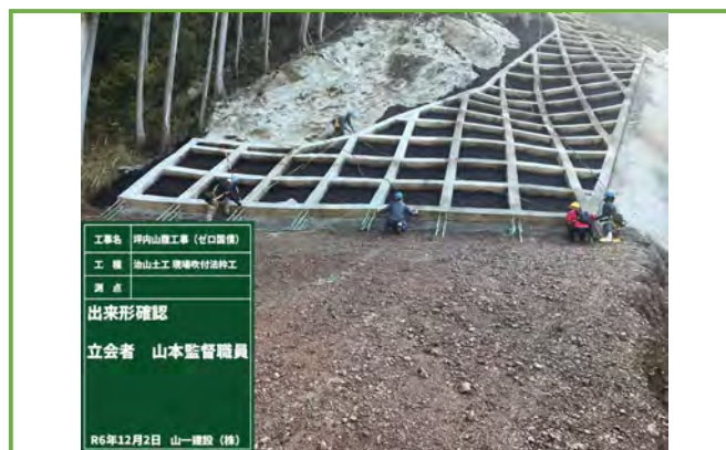
現地にて3次元データとの整合性確認
