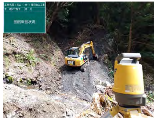
MCバックホウによる施工①
