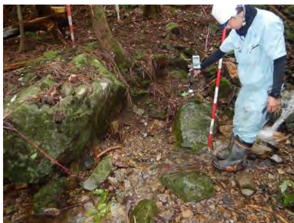
段階確認測量状況写真
