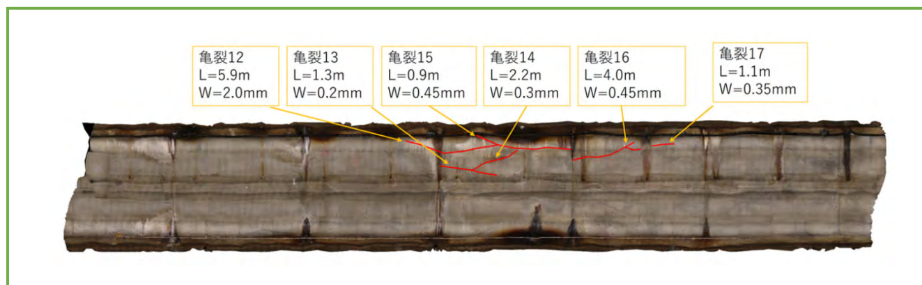
排水トンネル工点検 SfM解析による3次元モデル
