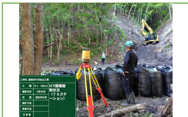
ICT建機掘削 (TSステーション)
