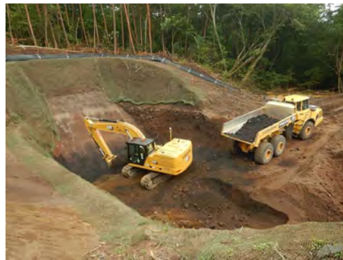
MCバックホウによる掘削状況
