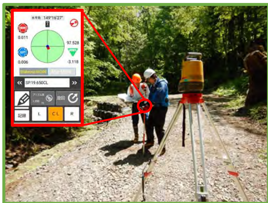
快測Scanによる3次元起工測量と 関連ソフトウェア 快測ナビ画面
