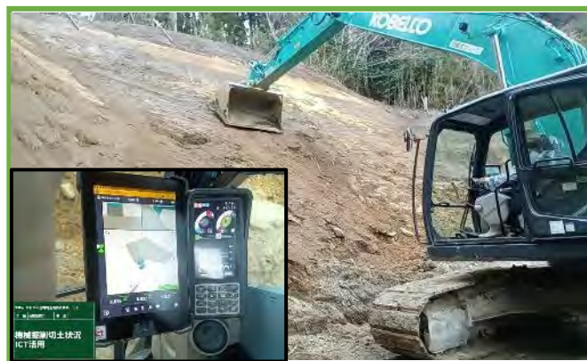
MCバックハウによる土工
