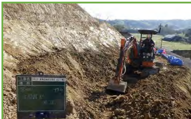
ICT機械による掘削状況
