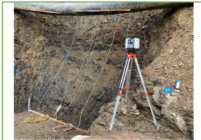
地上型レーザスキャナによる出来形計測
