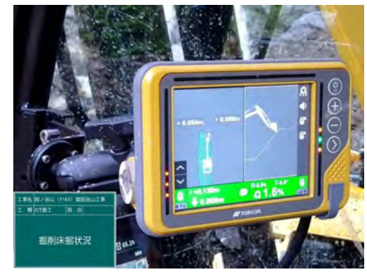
MCバックホウによる施工②
