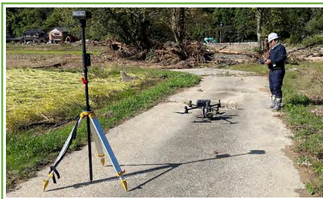
UAVレーザ測量状況
