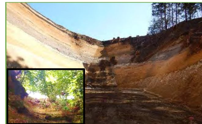
切土工施工前後状況
