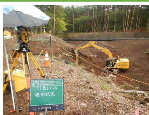
MCバックホウによる掘削状況
