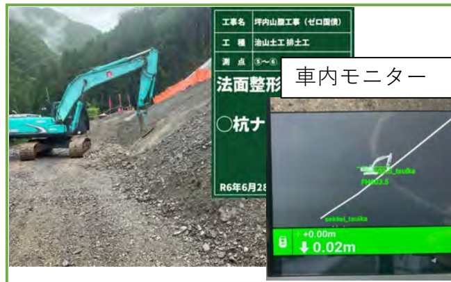
MGバックホウ施工状況（整形状況・車内モニター）
