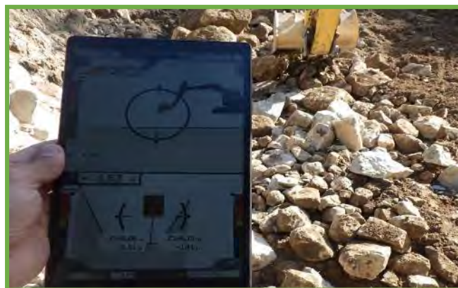
タブレット端末による掘削
