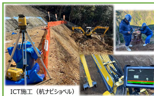
杭ナビショベルによるICT施工
