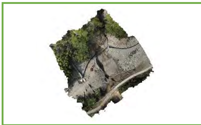
UAVによる測量（点群データ）
