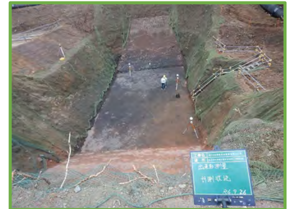
地上型レーザースキャナーによる出来形測量状況
