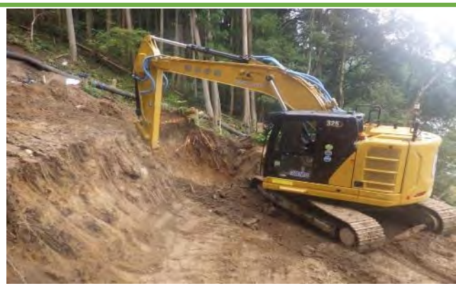
MGバックホウによる掘削
