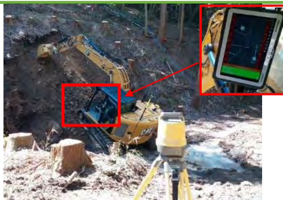
MGバックホウによる掘削作業
