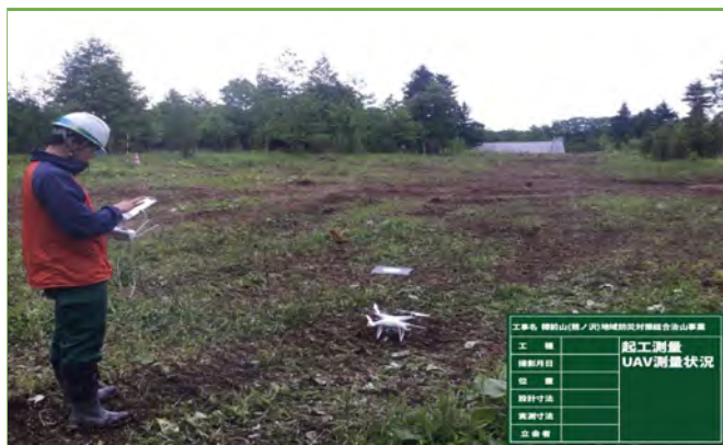
UAVによる起工測量
