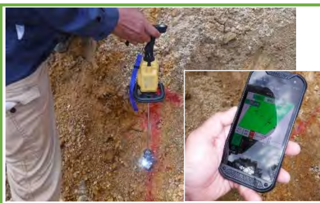
TS遠隔操作を用いた掘削前確認
