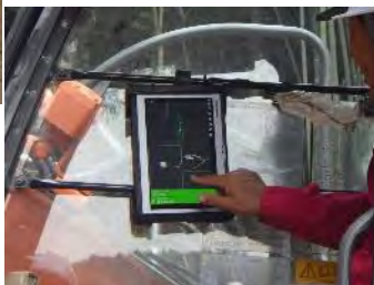
ICT機械による掘削
