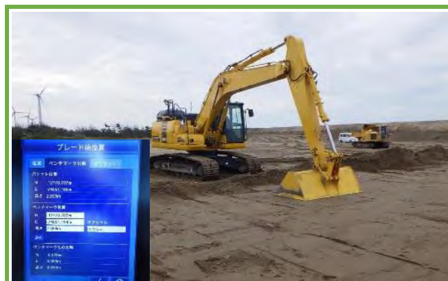
MCバックホウによる掘削
