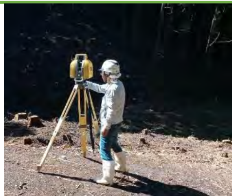
地上レーザースキャナーを用いた起工測量 （掘削前）
