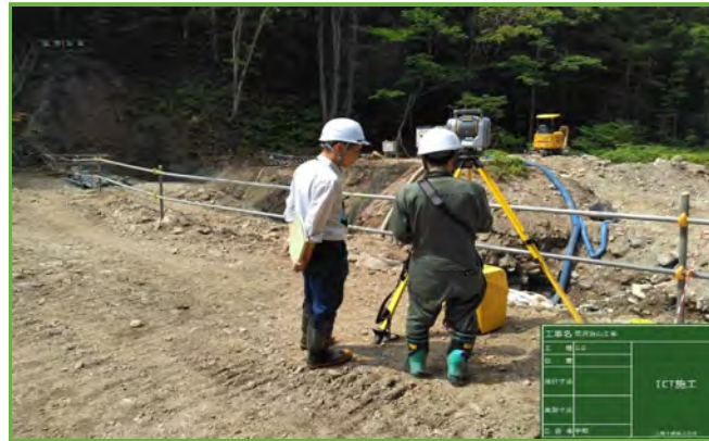
レーザースキャナーによる出来形測量状況
