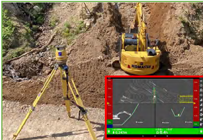
MGバックホウによる掘削(右下：作業モニター)
