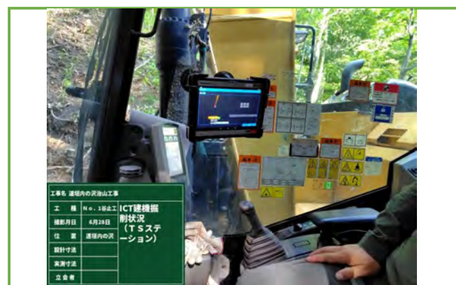
ICT建機掘削(運転席モニター)
