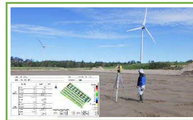
地上型レーザースキャナーによる出来形管理
