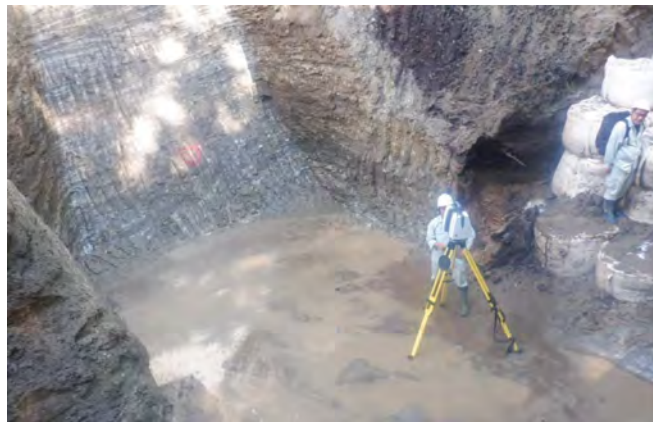
レーザースキャナを用いた出来形計測
