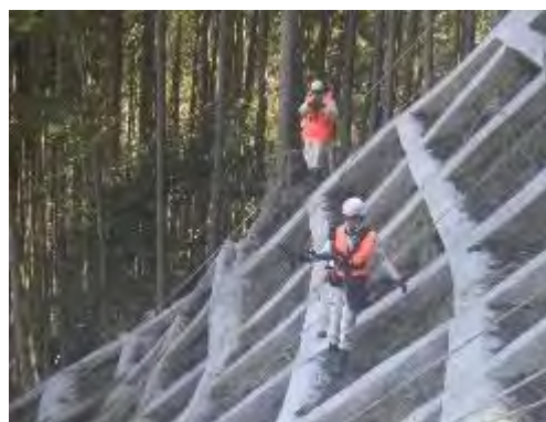
法枠出来形をICT機材でスキャン作業
