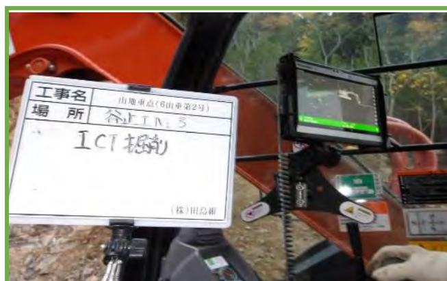
タブレット端末による掘削
