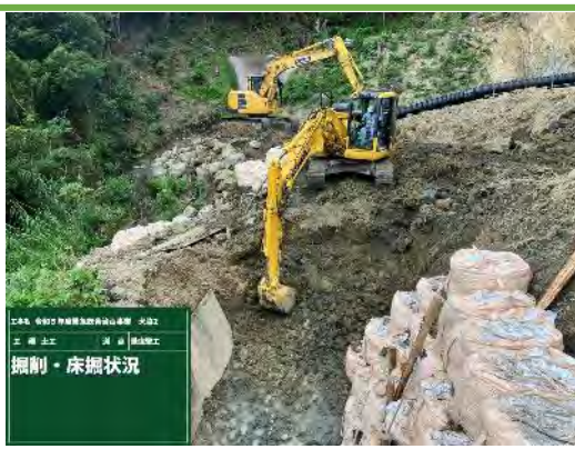
掘削・床掘状況
