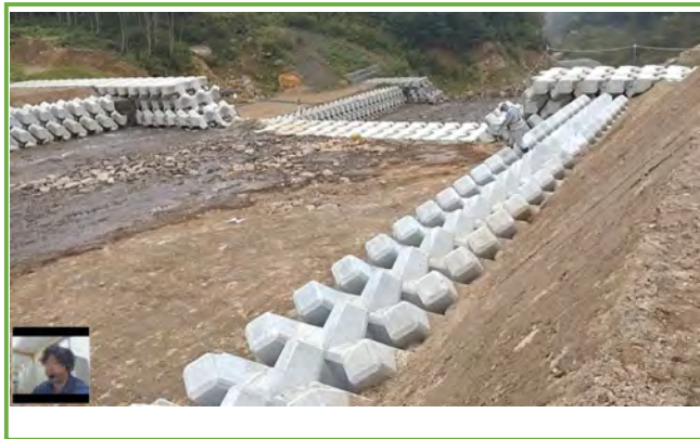
3次元データを基にした基準高測定（遠隔臨場）
