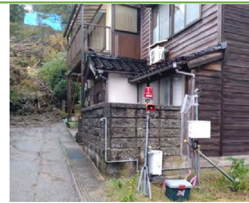
警報装置設置状況
