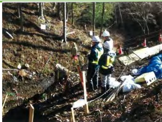
3次元起工測量（地上レーザースキャナ）
