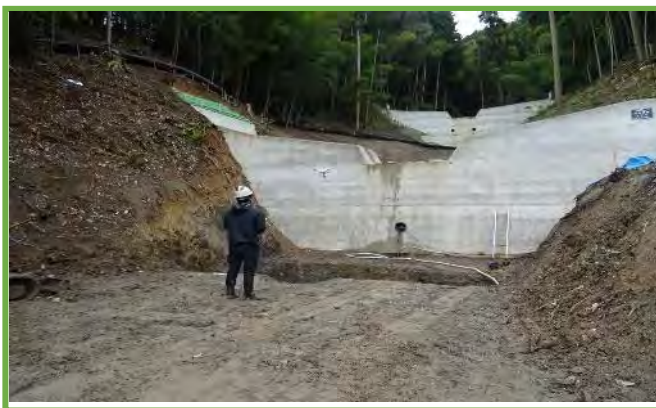
UAVによる測量
