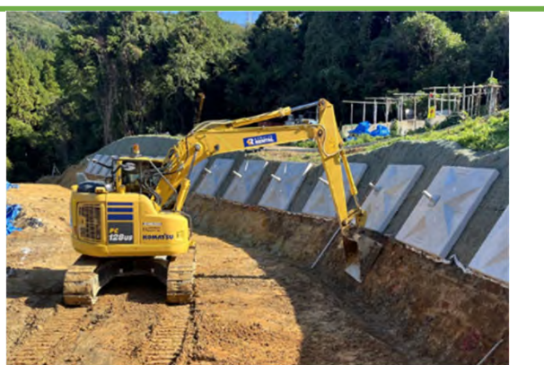
MGバックホウによる施工
