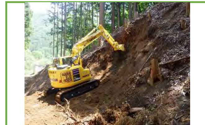
ICT建機稼働状況
