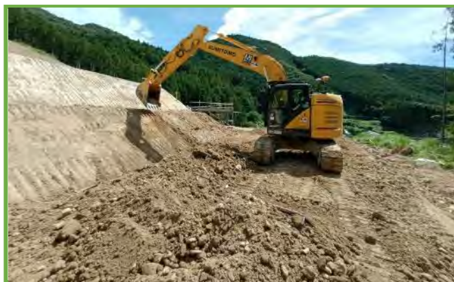
MGバックホウによる施工
