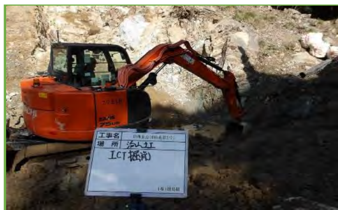
MGバックホウによる掘削作業
