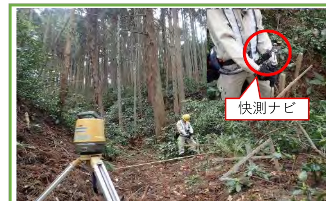
快測ナビによる丁張作業
