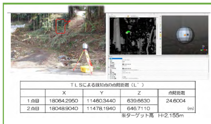
TLSによる起工測量
