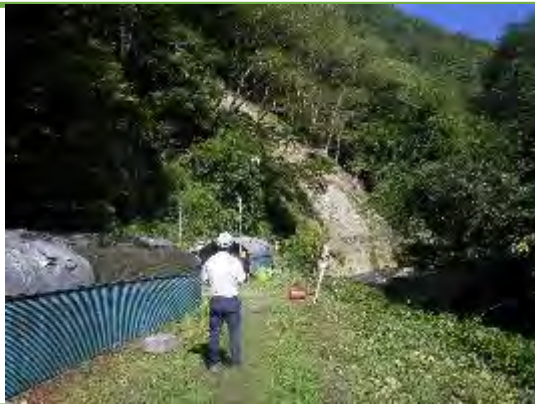
UAVによる3次元起工測量
