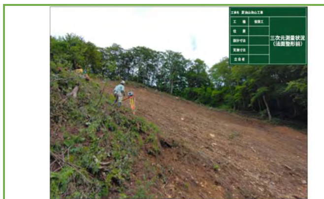
法面整形前の三次元測量
