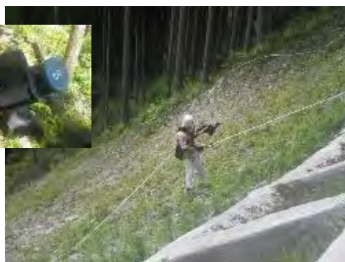
ICT機材と斜面のスキャン作業
