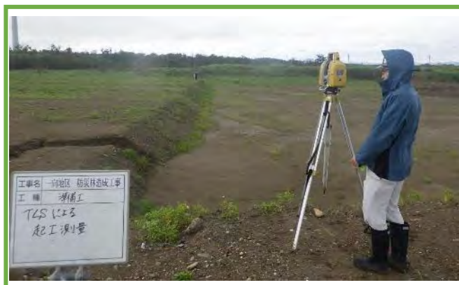
地上型レーザースキャナーによる起工測量
