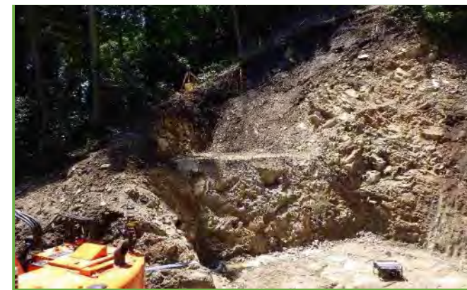
谷止工の掘削状況
