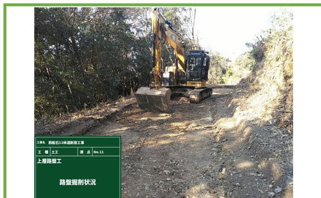
MGバックホウによる路盤掘削作業
