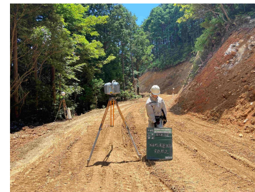
出来形測量（TLS）状況
