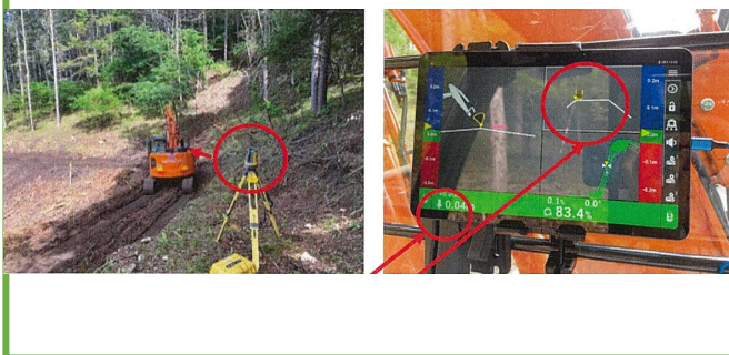
現地施工状況
