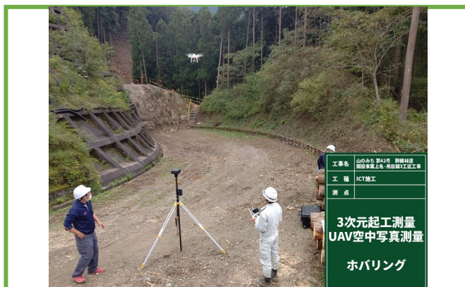
UAVによる空中写真測量
