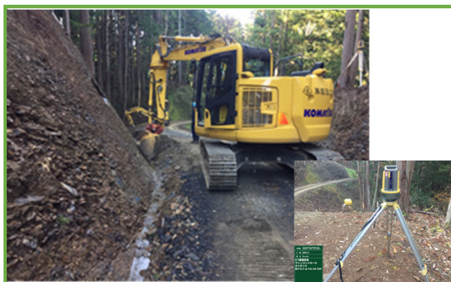
法面整形状況
