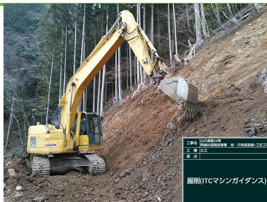
MGバックホウによる掘削作業
