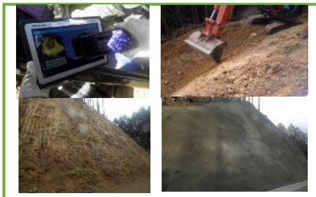
バケットやブレードの位置がリアルタイムで正確に把握でき、重機内のモニターで法面、路床の形状を確認することが可能で、高い精度で作業を進めることができた。
