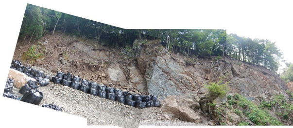
作業箇所全景
