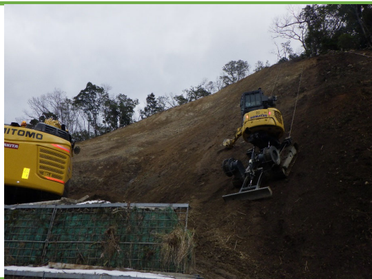
掘削状況（右側がMGバックホウ）
