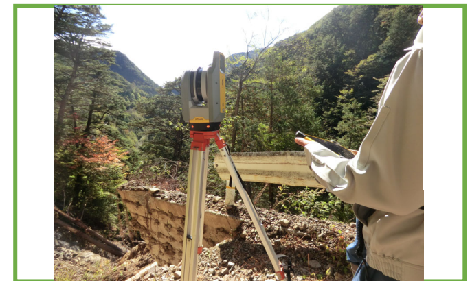
地上レーザによる測量
