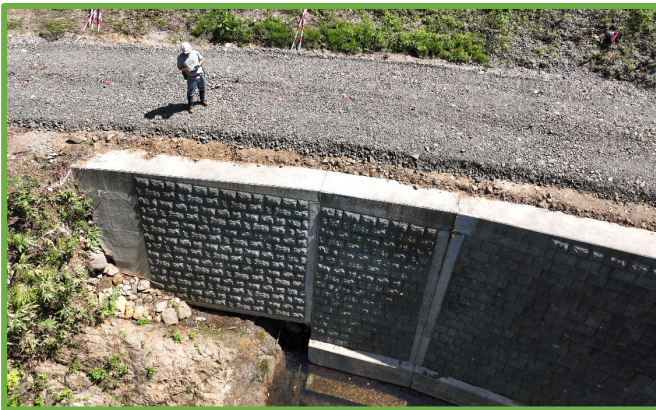
UAVによる作業状況
