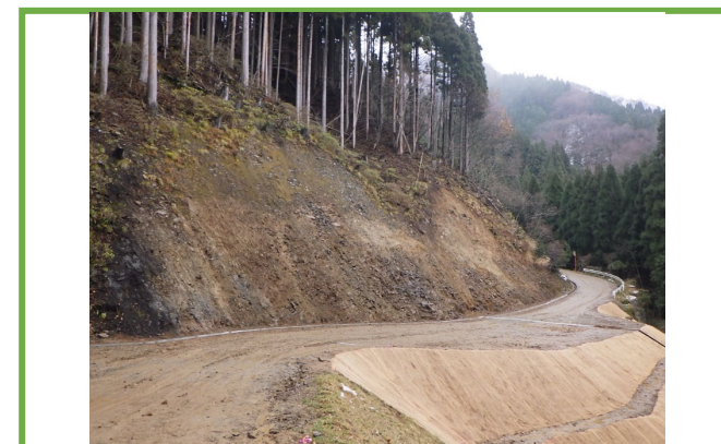
掘削・盛土法面出来栄
