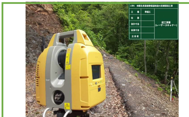
TLSによる起工測量
