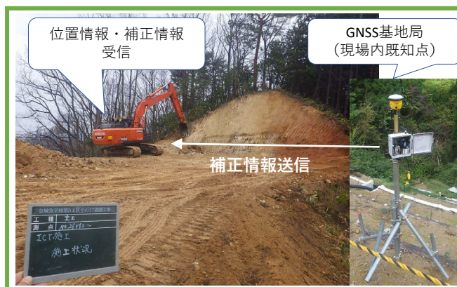
人工衛星から位置情報を、基地局から補正情報を受信し、高精度な位置情報を得て掘削
