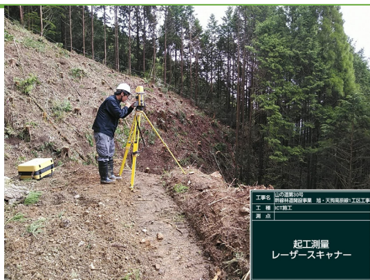
TLSによる起工測量
