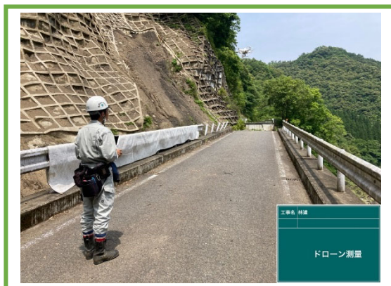
UAV測量—ドローン測量状況
