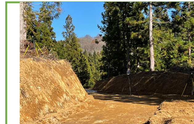
TLSによる出来形計測状況
