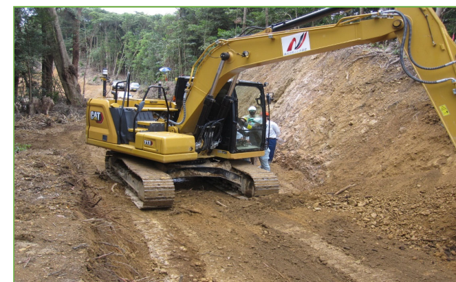
ICT建機による法面掘削
