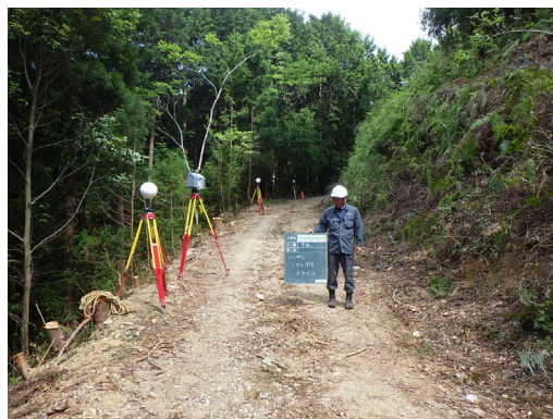
3次元測量実施状況
