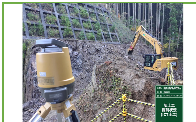
MGバックホウによる切土工
