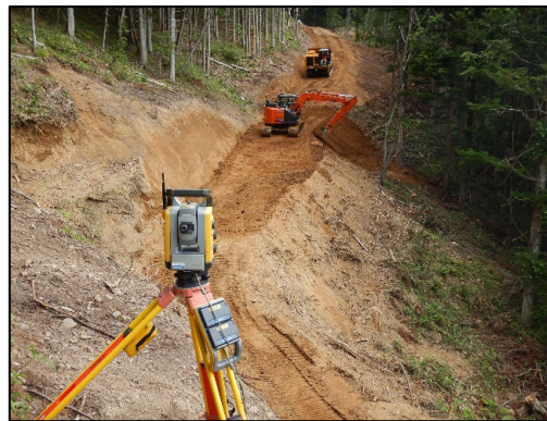
自動追尾型TSによるマシンガイダンス
