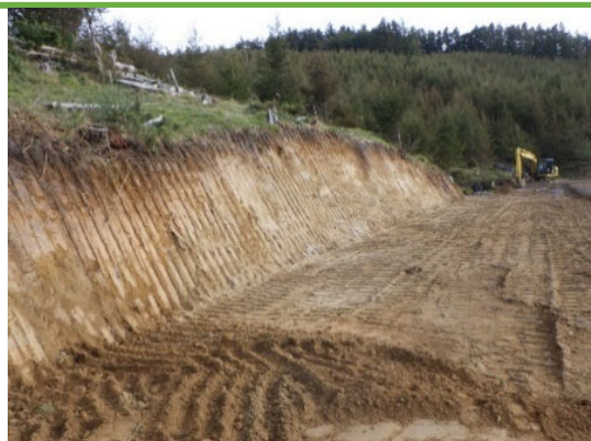
MGバックホウにより整形した法面
