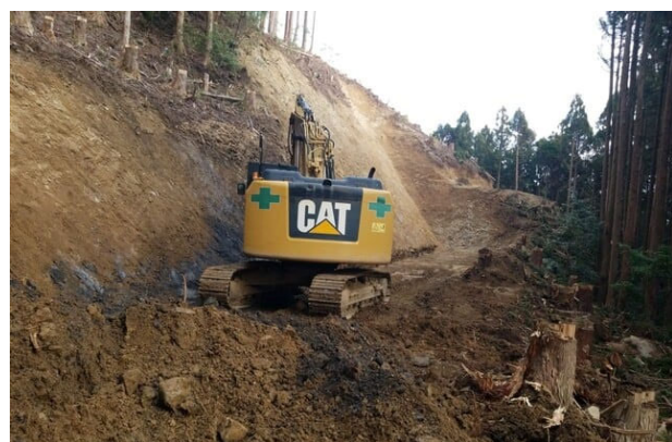
自動追尾式によるMG施工（丁張りレス）
