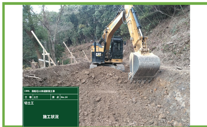
MGバックホウによる切土作業
