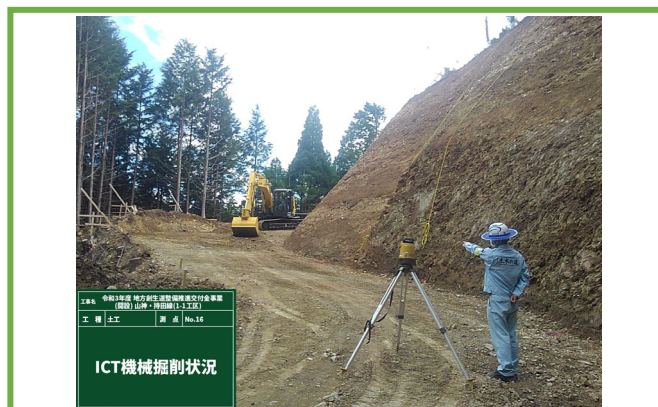
3DMGパツホウによる掘削状況
