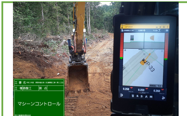
MC機械掘削時、運転席モニター
