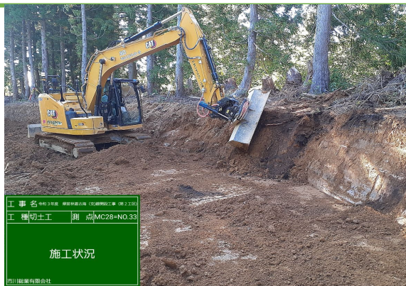
MC機械掘削(チルトローテーター使用)
