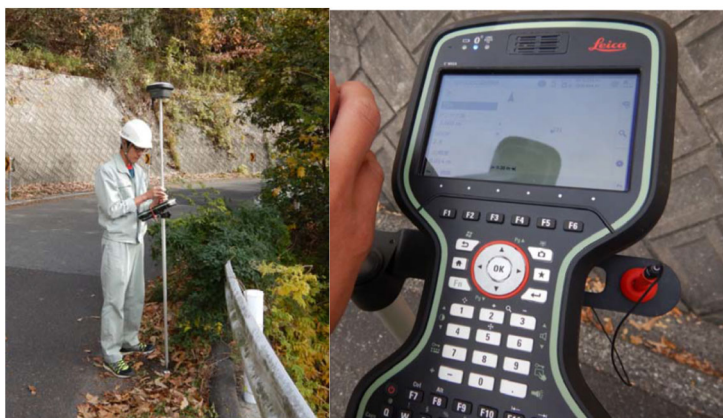
写真 4-1 RTK-GNSS測位器による観測状況 (Leica 社 GS18T)
