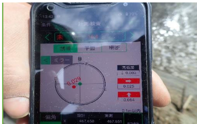
床掘確認 (座標で確認)
