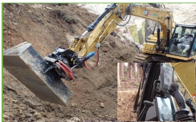
ICT建機施工 (床掘)
