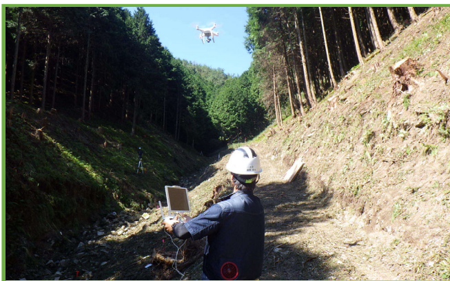
UAVによる起工測量状況
