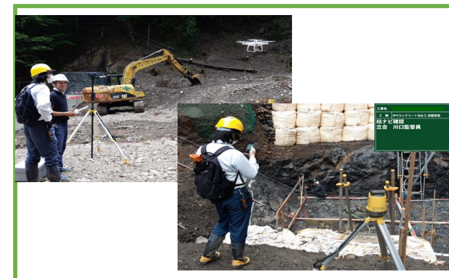
UAVによる出来形計測
