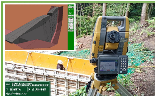
型枠組立時の測量作業 (左上: 3Dビュー)
