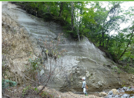
調査対象斜面現況
