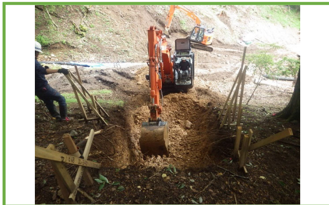
MGバックホウによる掘削
