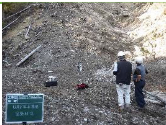
UAV写真測量 フライト実施状況
