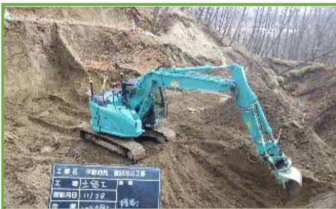
バックホウ（マシンダブ）による床堀
