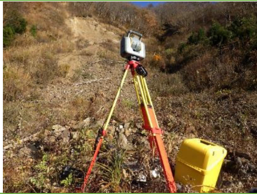
山腹面全体の測量する3Dレーザー scanner (ニコン: Trimble X10)
