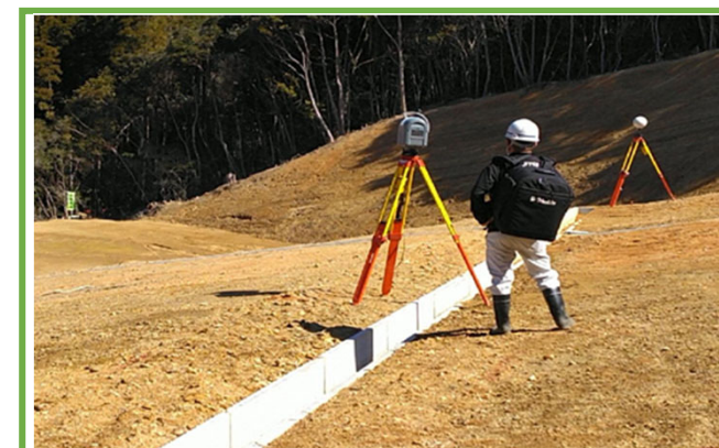
TLSによる出来形管理
