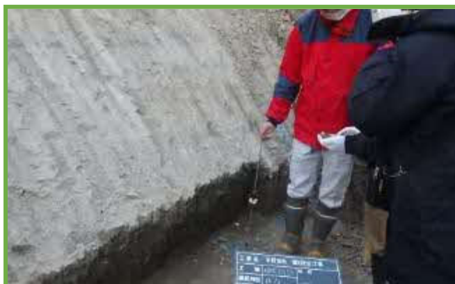
TSによる床掘面の出来型測定状況
