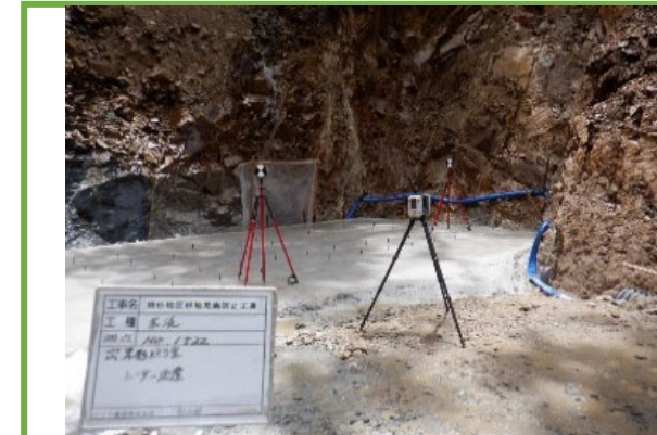
レーザースキャンによる出来形管理
