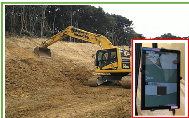
MGA ® ツクサによる法面整形（右下：モニター）
