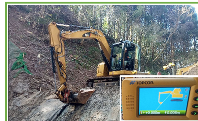
2Dショベルガイダンスを使用した法面整形作業
