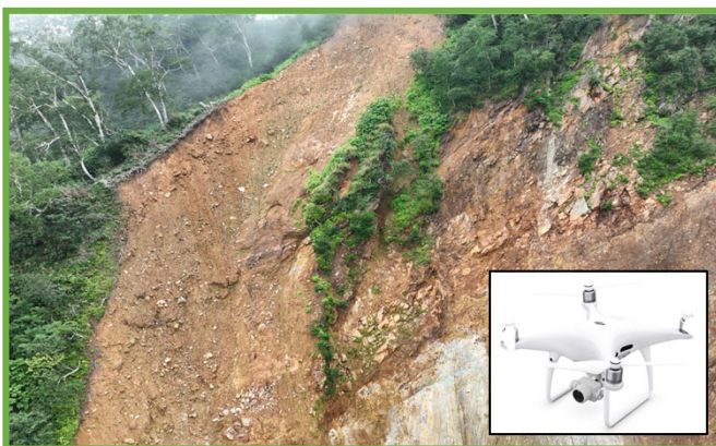
ドローン写真測量箇所及び 測量に使用したドローン
