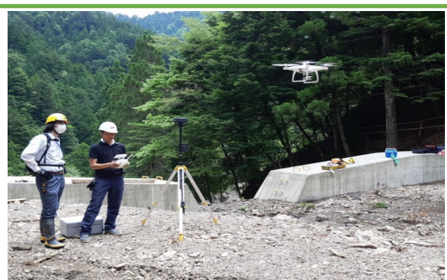
UAV（ドローン）を活用した起工測量
