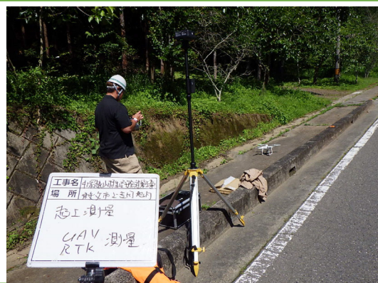
起工測量の様子
