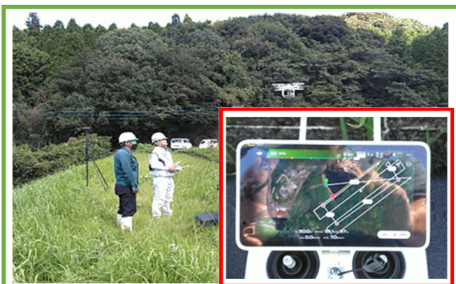
UAVによる三次元起工測量
