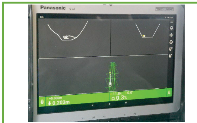
ICTバックホウ機内に装備された同期モニター
