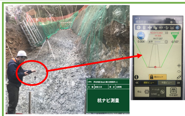
床堀の3次元データを活用し、測定位置の幅、高さなどをリアルタイムで確認
