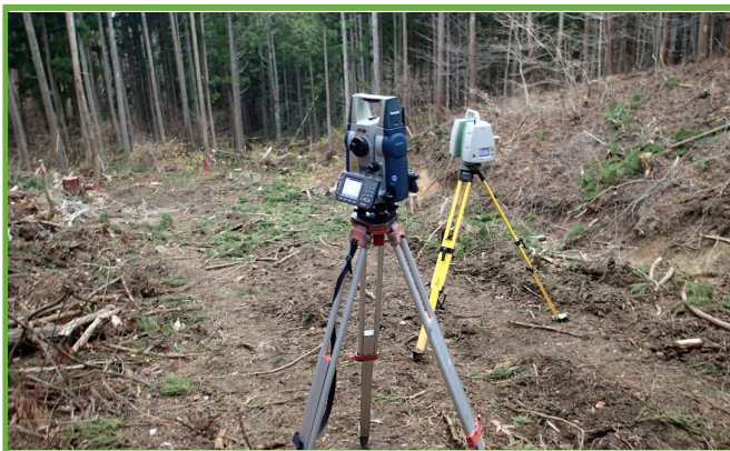
レーザースキャナを用いた起工測量
