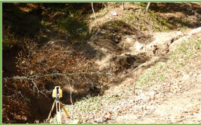
地上型レーザー scanner による起工測量
