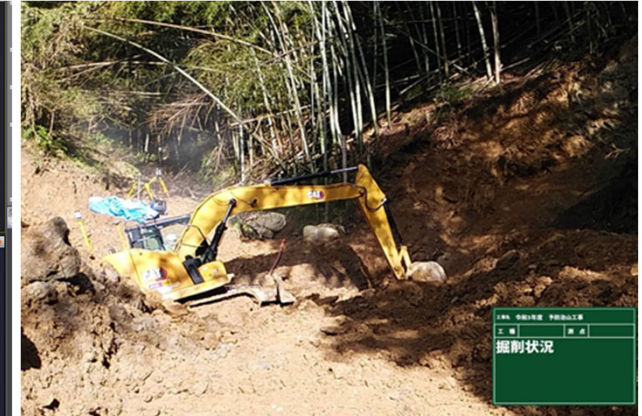
MGバックホウによる掘削
