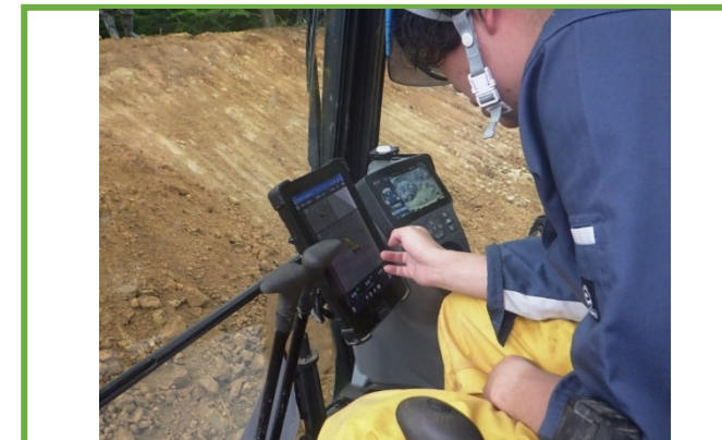
モニターでバケット位置をリアルタイムに確認
