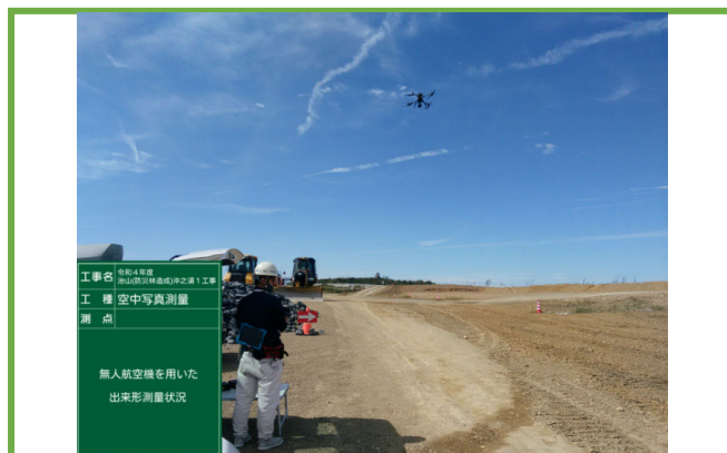
空中写真による出来形計測
