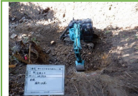
MGバックホウによる掘削
