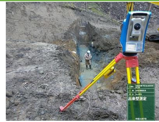
トータルステーション等による床掘の基準高の測定（出来形管理）
