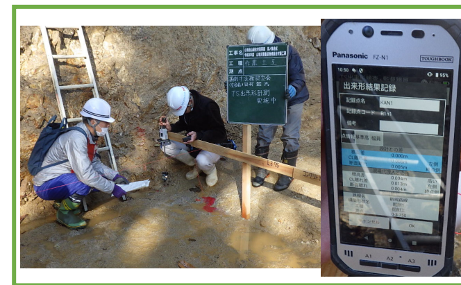
TS出来形計測 実施状況
