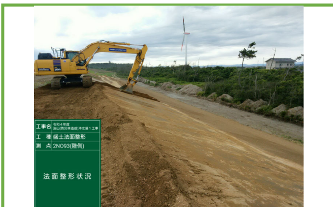
3D-MCバックホウによる法面整形
