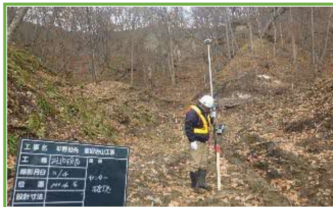
RTK-GNSSによる起工測量
