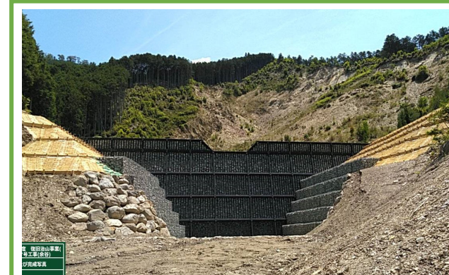
完成写真 (正面)
