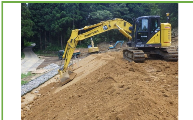
ICT建設機械による盛土法面整形
