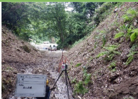
レーザースキャンによる起工測量
