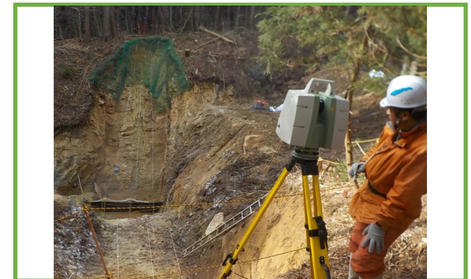
レーザースキャナを用いた出来形測量
