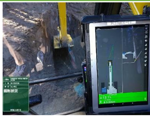
MGバックホウによる床掘
