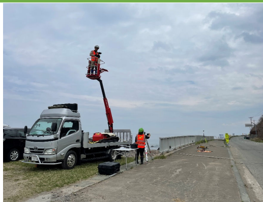
UAV測量実施状況
